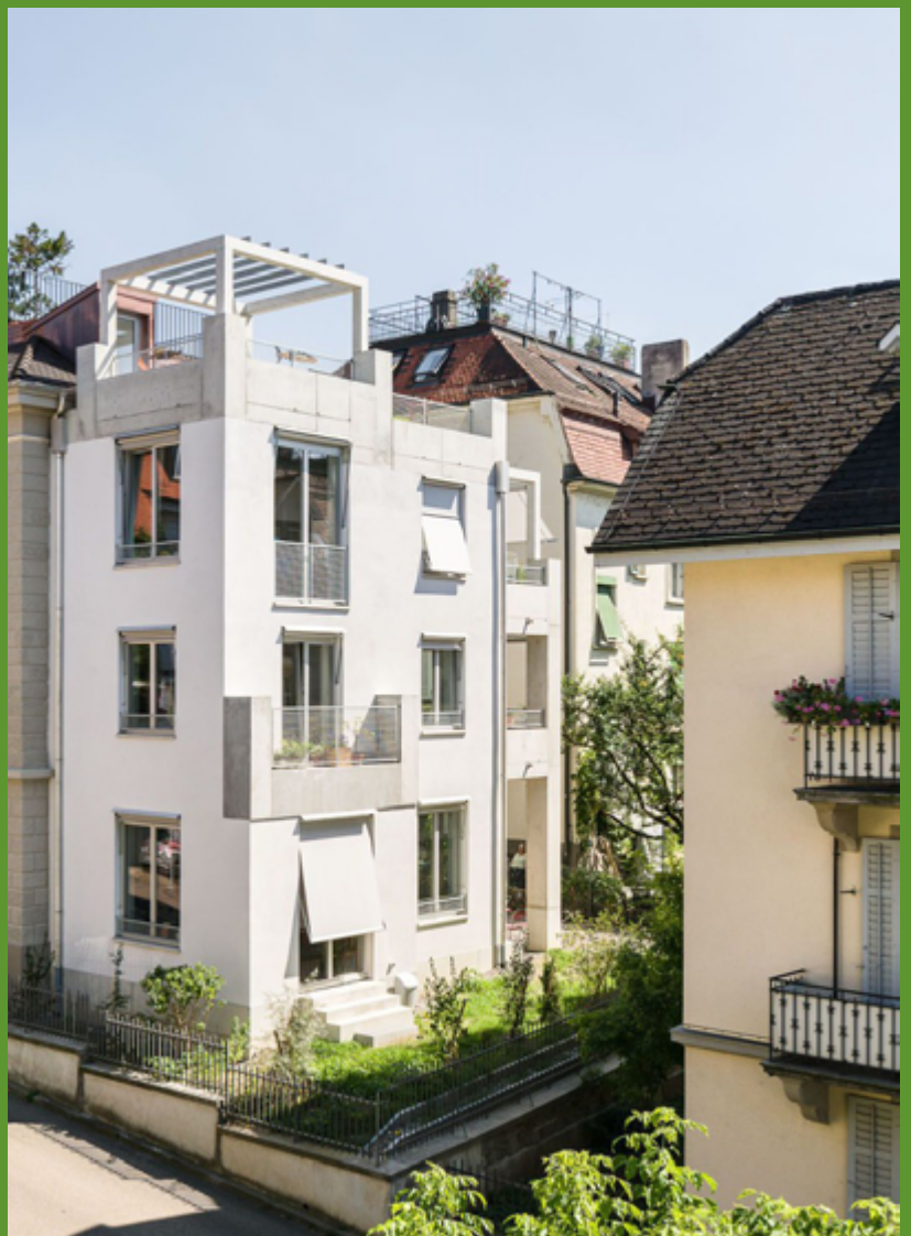
Nieuw en oud wonen naast elkaar in de Fliederstrasse, Zürich, Conen Sigl Architekten
