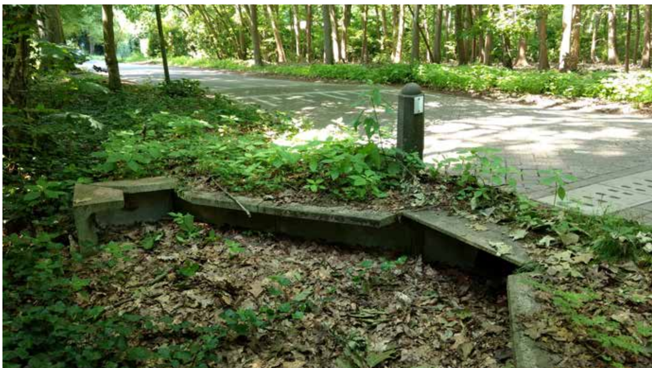
▲ Voorbeeld van een goed aangelegde amfibievoorziening (Kerkedreef & Miksebaan Brasschaat) Foto © Ilf Jacobs
