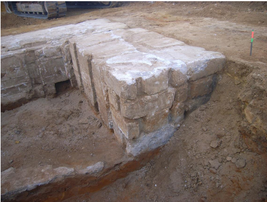
Figuur 20: De noordelijke muur van de constructie (noordoosthoek). Let op de vier betonbloklagen en de plankafdrukken bij de gegoten stukken. De bovenste blok aan de hoek werd in detail ingetekend (zie Figuur 17).
