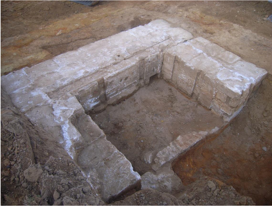
Figuur 19: Zicht op de vrijgelegde U-vormige constructie. Zicht naar het noordwesten. Opnieuw vallen de uitsparingen voor verticale balken en voor een horizontale metalen staaf op. In de noordwesthoek is onderaan een holte uitgespaard.
