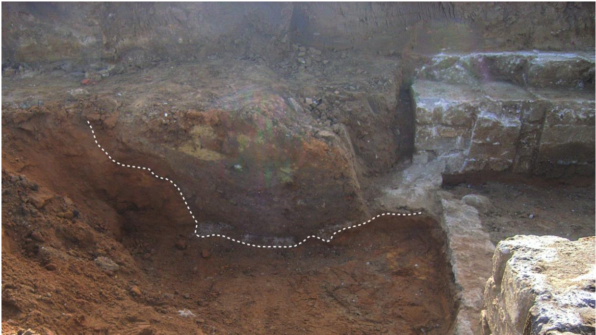
Figuur 21: Doorsnede op de aanlegput haaks op de oostkant van de betonconstructie.
