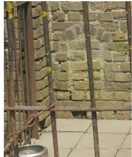
Fig. 151: dichtgemetselde opening van in de schuur geïntegreerd hondenhok op de wederopbouwhoeve in de Zonnebekestraat 99 in Langemark (Onroerend Erfgoed, F. Becuwe).
