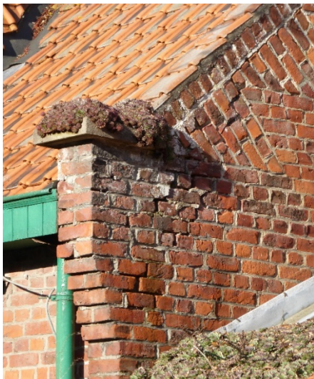
Fig. 41: gevel met vlechtingen en schouderstuk op de hoeve Boskasteel* in Poelkapelle (Onroerend Erfgoed, F. Becuwe).
