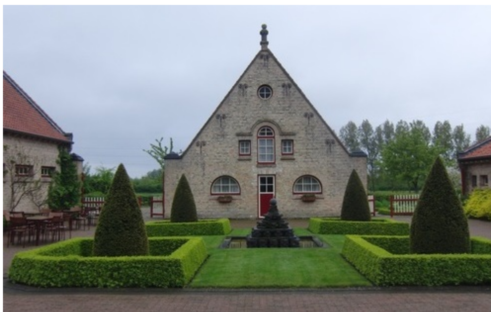
Fig. 114: het kippen- en konijnenhok met achterliggende overdekte mestvaalt op de kasteelhoeve Vicogne* in Stuivekenskerke, ontworpen door architect Camille van Elslande (Onroerend Erfgoed, P. Vanneste).
