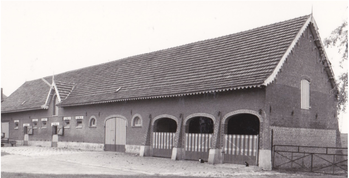
Fig. 142: het wagenhuis in het verlengde van de schuur op de hoeve Busschaertlinde* in Kemmel (Onroerend Erfgoed, fotoarchief).
