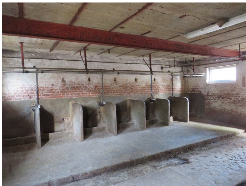
Fig. 77: betonnen tussenschotten in de koestal van de Pollepelhoeve in Zillebeke. Zie ook het plafond van tussen I-profielen gevatte betonnen gewelven (Onroerend Erfgoed, F. Becuwe).
