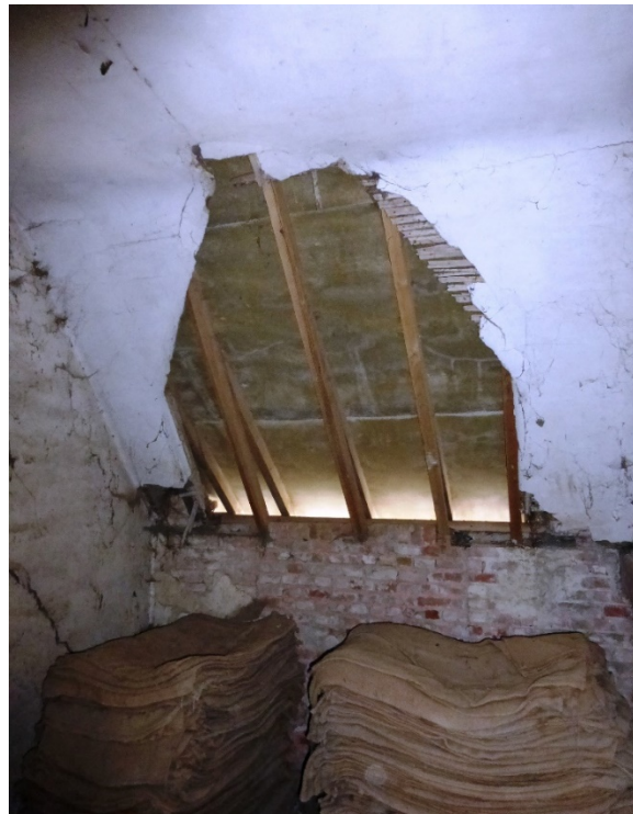
Fig. 83: gepleisterd plafond op het voor de huisvesting van de knechten voorbehouden deel van de zolder boven de koestal van de hoeve Pilgrimshof* in Wijtschate (Onroerend Erfgoed, V. Debonne).
