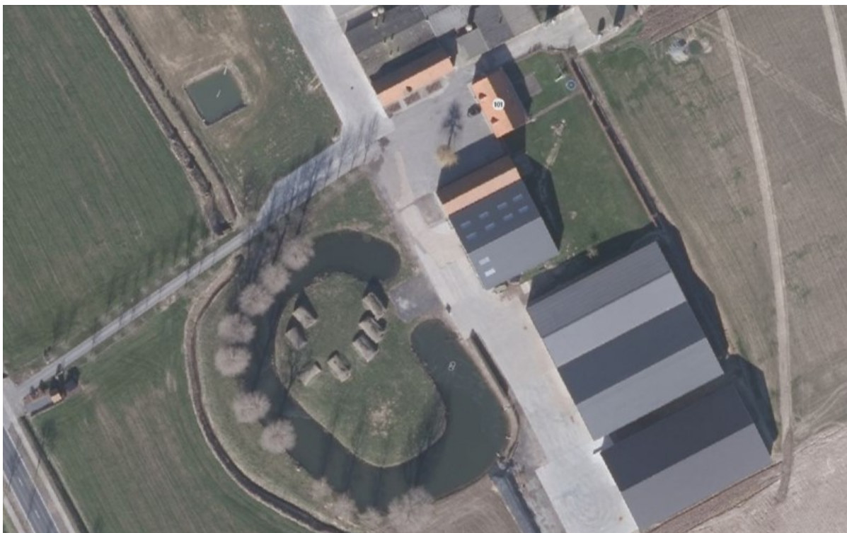
Fig. 17: luchtfoto van de heropgebouwde hoeve 't Langhof in Zillebeke met op het omwalde opperhof Britse bunkers (Geoportaal - geo.onroerenderfgoed.be).
