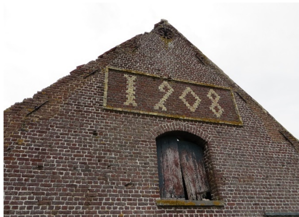
Fig. 11: het op de zijgevel van de schuur vermelde jaartal “1908” op de hoeve in de Vlamertingestraat 61 in Vlamertinge (Onroerend Erfgoed, P. Vanneste).
