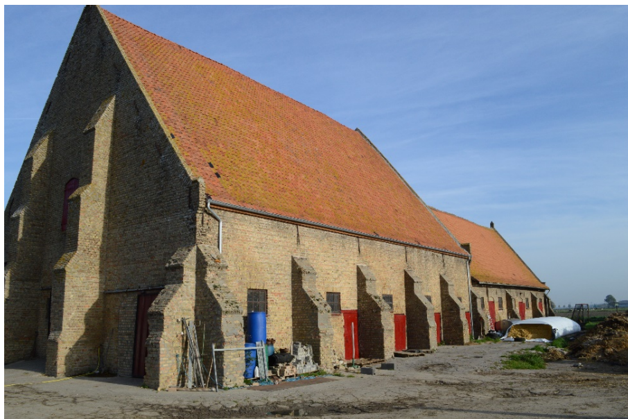
Fig. 127: de langsschuur op de hoeve De Kleine Bamburg* in Westende, ontworpen door architect Théodore Raison (Onroerend Erfgoed, F. Becuwe).
