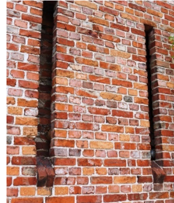
Fig. 133: asemgat in de schuur op de Foch Farm* in Boezinge (Onroerend Erfgoed, V. Debonne).
