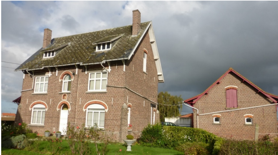
Fig. 48: boerenwoning met twee bouwlagen op de hoeve in de Oude Boezingestraat 1 in Elverdinge. De hier toegepaste overkragende dakranden werden in de modelboeken voor de wederopbouw afgeraden (Onroerend Erfgoed, P. Vanneste).
