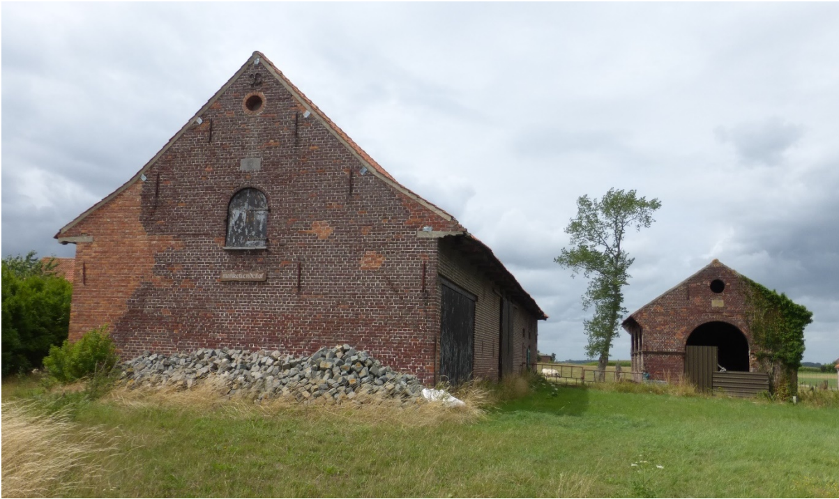
Fig. 13: de hoeve Manquetiendehof in Dikkebus liep beperkte oorlogsschade op. Na de oorlog werd een hoek van de schuur hersteld in nieuwe baksteen (Onroerend Erfgoed, P. Vanneste).
