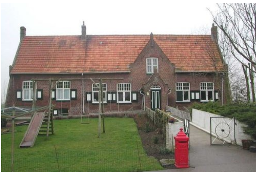
Fig. 45: boerenhuis met buitenportaal van de wederopbouwhoeve in de Molenstraat 16 in Pervijze, ontworpen door Camille Van Elslande (Onroerend Erfgoed, P. Vanneste).
