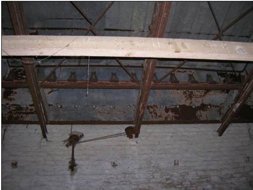
Fig. 153: kantelbare eestvloer in de hopast op het Ravenshof in Vlamertinge (© De Keteniers).
