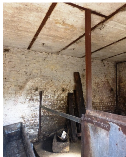
Fig. 81: het door Van Overmeire & Devos voorziene betonplafond in de stallen op het West-Bellegoed in Voormezele (Onroerend Erfgoed, P. Vanneste).
