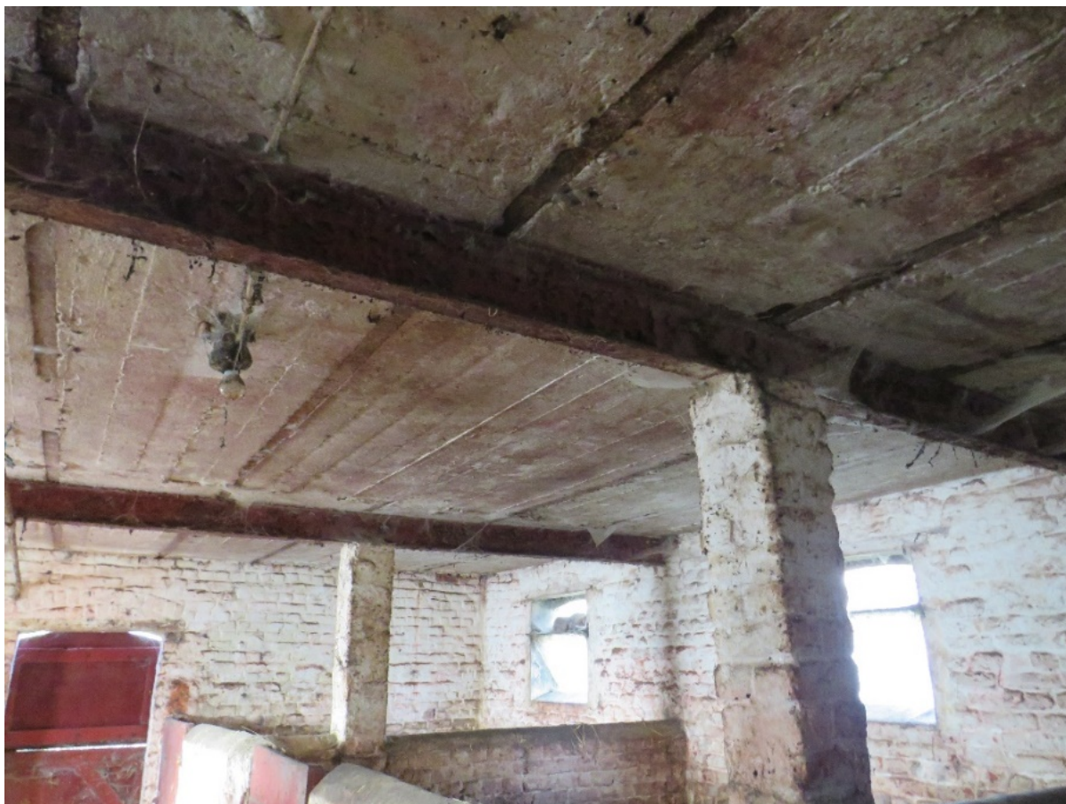
Fig. 105: de van een betonnen plafond voorziene varkensstal van de Pollepelhoeve in Zillebeke (Onroerend Erfgoed, F. Becuwe).
