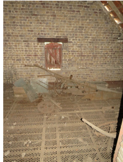
Fig. 167: de geperforeerde eestvloer van de cichoreiast op het West-Bellegoed in Voormezele (Onroerend Erfgoed, F. Becuwe).
