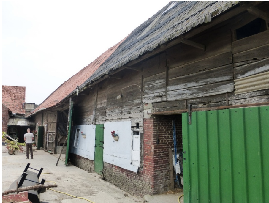
Fig. 126: de schuur- en stalveugel van de hoeve in de Nieuwkerkestraat 49 in Nieuwkerke, bestaande uit een in baksteen heropgebouwd noordelijk gedeelte en een houten gedeelte van omstreeks 1800 (Onroerend Erfgoed, F. Becuwe).
