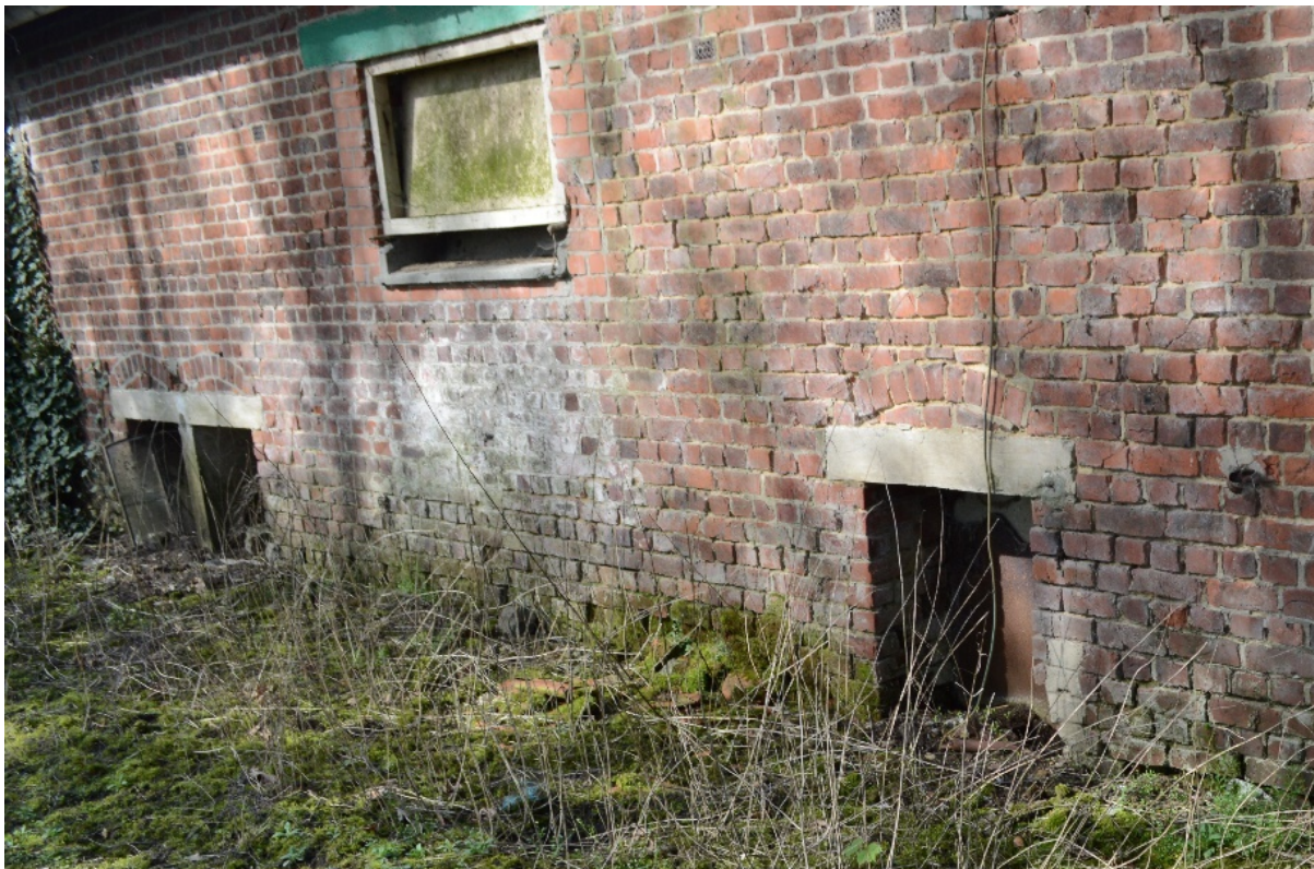
Fig. 104: afgesloten openingen tussen de hokken van de varkensstal en de loopzones buiten op de hoeve Boskasteel* in Poelkapelle (Onroerend Erfgoed, F. Becuwe).
