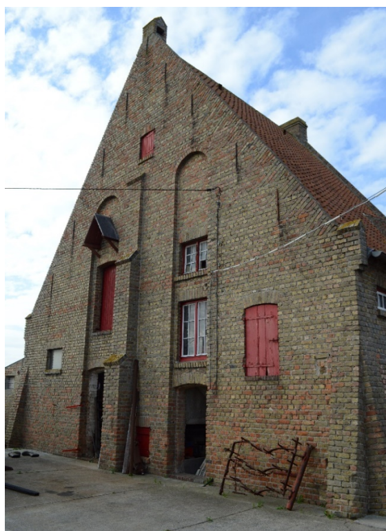
Fig. 99: de paardenstal, in het verlengde van de koestal met tussenliggend voederhok op de wederopbouwhoeve 't Geuzegat* in Mannekensvere, ontworpen door Jules Heyneman en Alfred Neiryck (Onroerend Erfgoed, © F. Becuwe).
