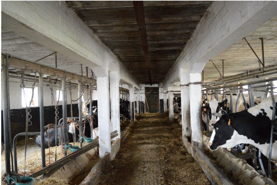
Fig. 52: de betonnen zoldering in de koestal van de hoeve Oosthof* in Ramskapelle (Onroerend Erfgoed, F. Becuwe).
