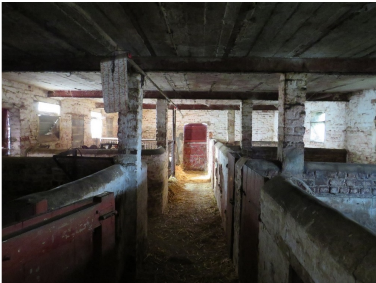
Fig. 102: varkensstal met centrale voedergang op de Pollepelhoeve in Zillebeke (Onroerend Erfgoed, F. Becuwe).
