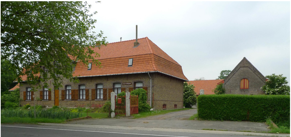
Fig. 37: de boerenwoning met naar de straat gerichte representatieve voorgevel en voortuin van de wederopbouwhoeve West-Bellegoed in Ieper, ontworpen door architect Cyrille Schmidt (Onroerend Erfgoed, E. Vanderhispallie).
