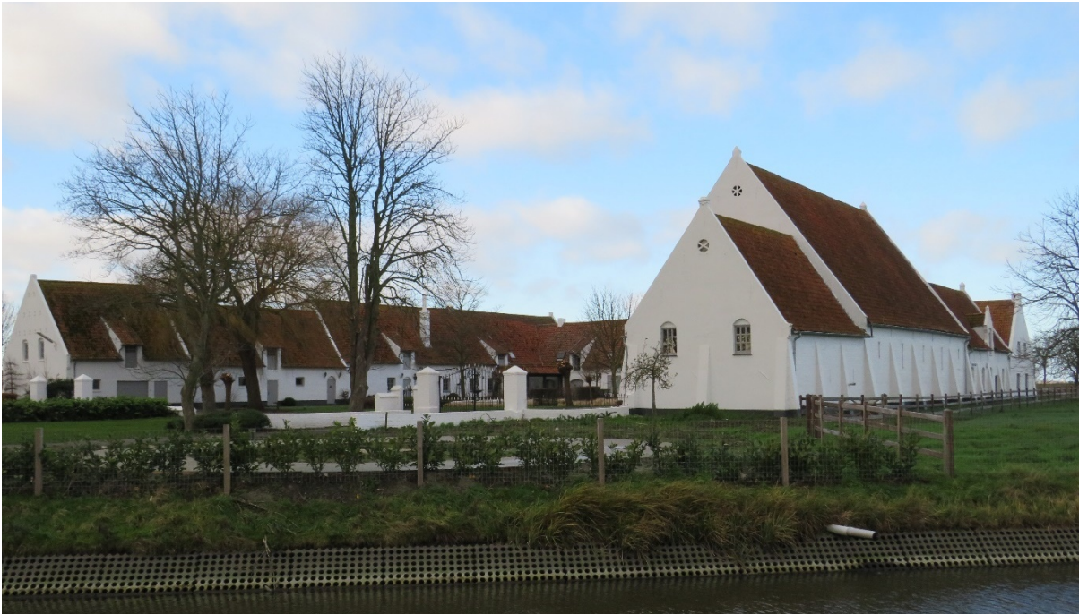
Fig. 40: de Schoorbakkehoeve in Schore als één van de weinige witgekalkte wederopbouwhoeves met zwart gepikte plint (Collectie F. Becuwe).
