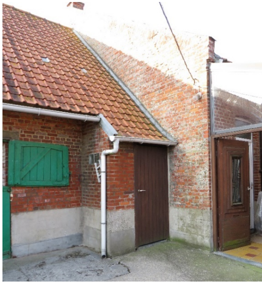
Fig. 54: het buitentoilet in de oksel van de koestal en de boerenwoning op de hoeve in de Diksmuidseweg 97 in Ieper (Onroerend Erfgoed, F. Becuwe).
