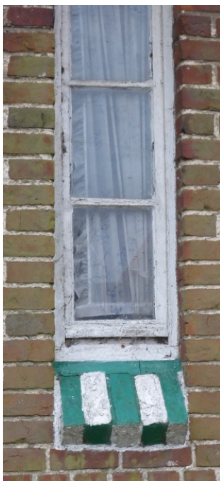
Fig. 56a: smal vensterraam met bakstenen afzaat in de boerenwoning van de wederopbouwhoeve in de Diksmuidestraat 21 in Bikschote (Onroerend Erfgoed, F. Becuwe).
