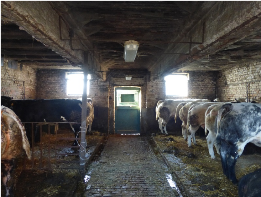
Fig. 70: de koestal op de hoeve in de Zonnebekerstraat 99 in Langemark beantwoordt aan het derde model. Hierbij is de centrale voedingang geflankeerd door twee goten (Onroerend Erfgoed, F. Becuwe).
