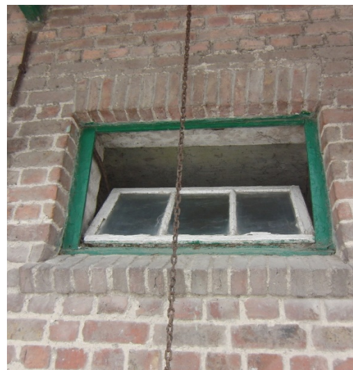
Fig. 85: kantelraam in stalling op de Kasteelhoeve in Beerst (Onroerend Erfgoed, P. Vanneste).
