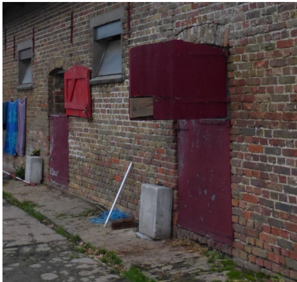
Fig. 92a: staldeur van de koestal op de hoeve in de Peperstraat 11 in Langemark (Onroerend Erfgoed, P. Vanneste).
