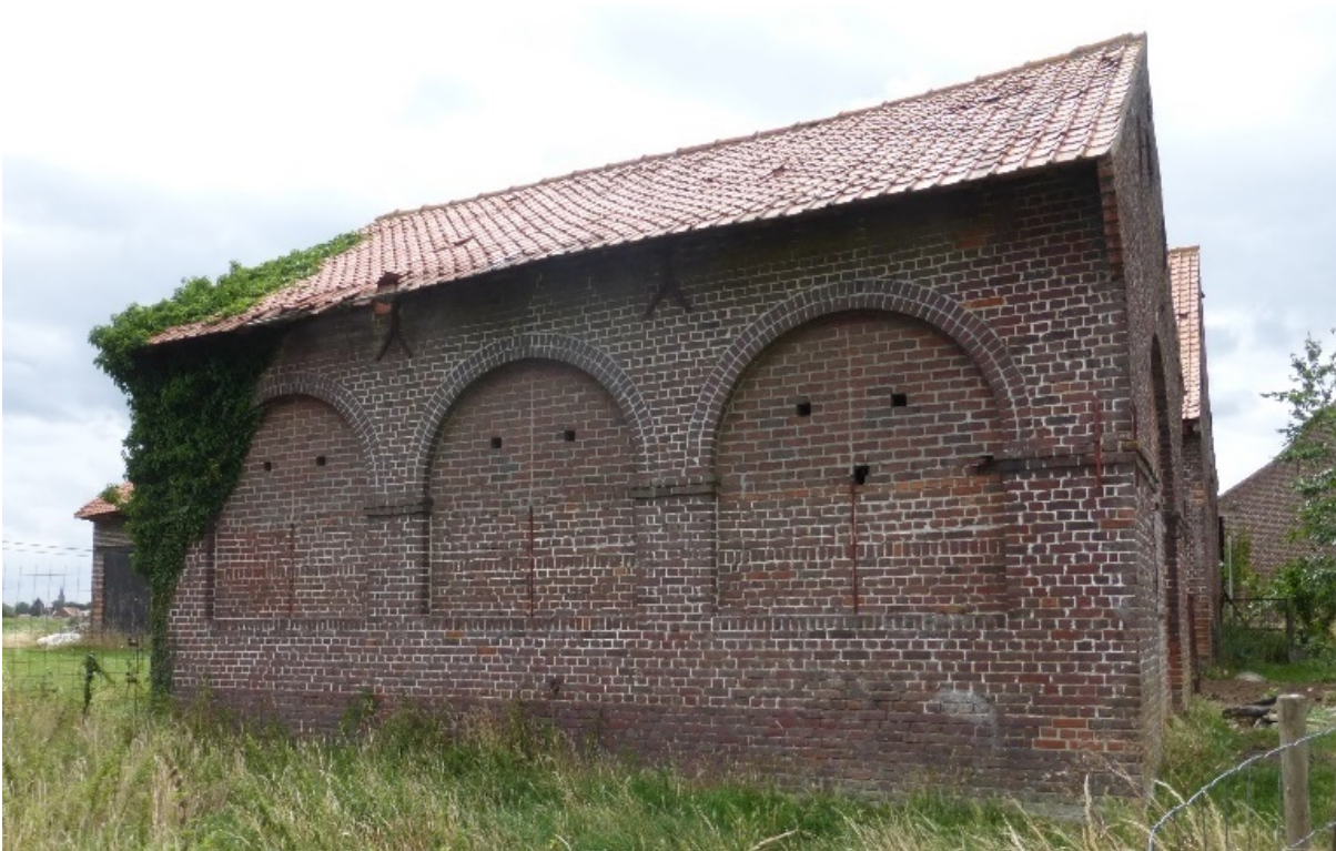
Fig. 120: overdekte mestvaalt van 1895 op de hoeve Manquetiendehof in Dikkebus (Onroerend Erfgoed, P. Vanneste).
