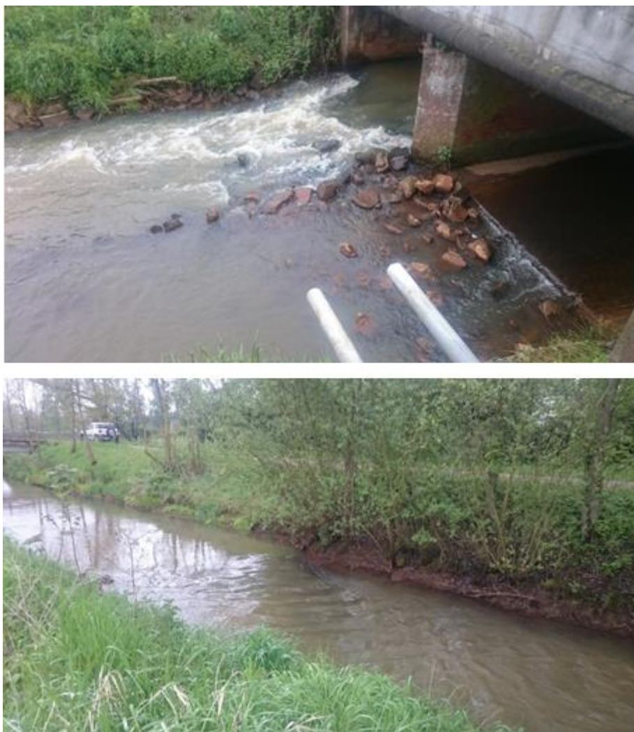
Figuur 81 Riffles stroomafwaarts van de vistrap te Meerhout. Boven: riffle onder de brug te Meerhout. Onder: riffle meer stroomafwaarts van de brug.
