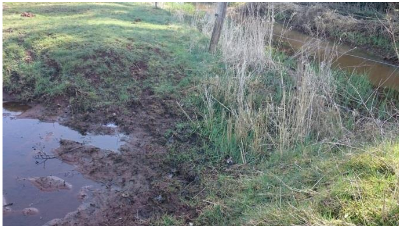
Figuur 60 De monding van de grachten in de Grote Nete zijn voorzien van een buis onder de verhoogde oeverwal (situatie februari 2018).
