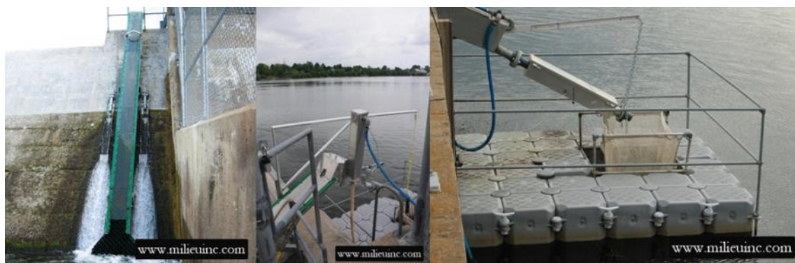
Figuur 20 De palingsgoot met een optisch vistelsysteem aan de Chambly dam op de Richelieu river, (Québec, Canada) ontwikkeld door MilieuInc.
