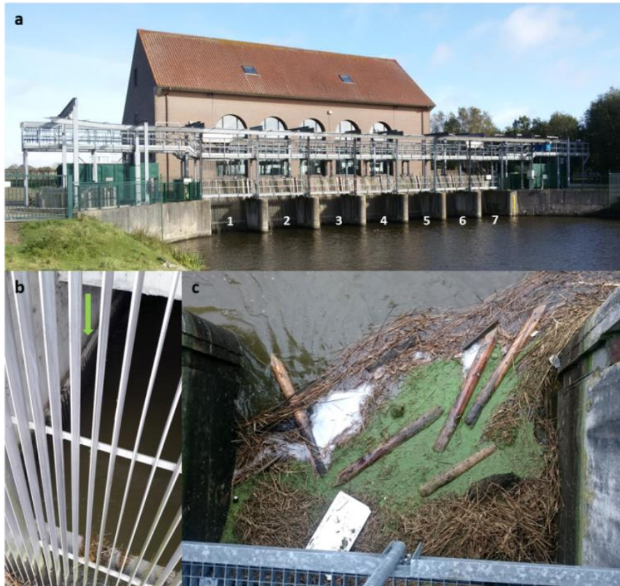
Figuur 6 De stroomopwaartse zijde van het pompgebouw met aanduiding van de 7 aanvoerkanalen waaronder 2 gravitaire (kanaal 1 en 7) en 5 pompkanalen (a), zicht doorheen de vuilroosters op de binnenzijde van een pompkanaal met aanduiding (groene pijl) van de met een gravitair aanvoer kanaal gedeelde wandopening die is voorzien van een traliwerk (b), sterke ophoping van drijfvuil stroomopwaarts het vuilrooster van kanaal 2 op 7 december 2017 (c).
