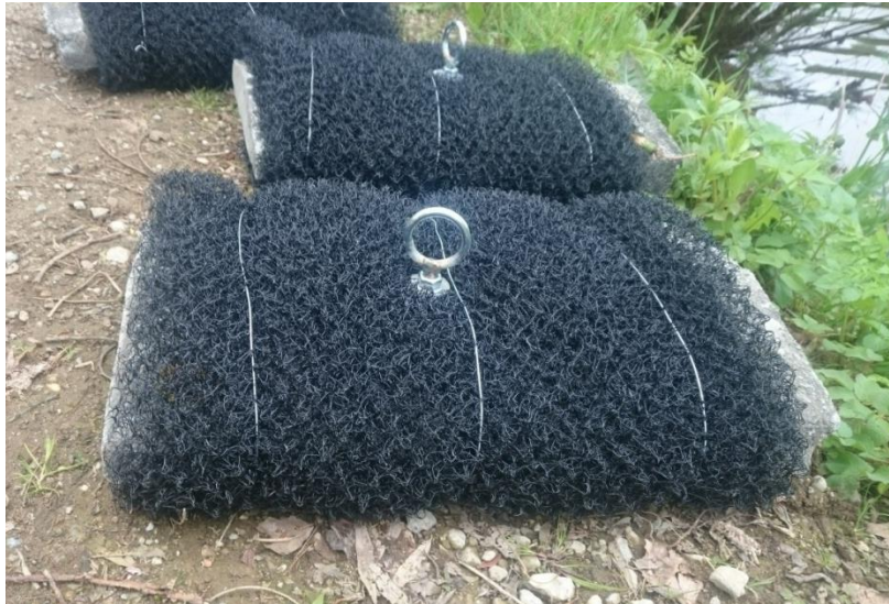
Figuur 82 Paaimatten geconstrueerd door een zware platte steen te voorzien van een metalen lus en 4 lagen enkamat.
