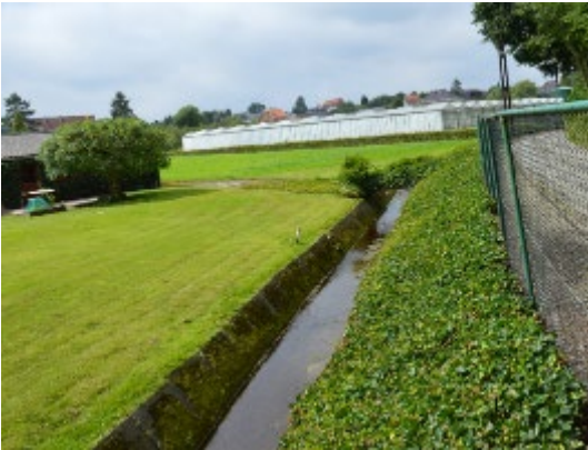
Afbeelding: Voorbeelden slechte beekstructuur: Nellebeek in betonnen kuip t.h.v. Lindaal (links) en start ingebuisd traject Nellebeek t.h.v. Kaalheide (rechts)
