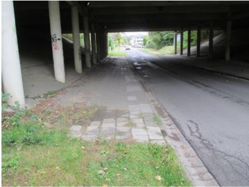
Foto: Viaduct Esdoornenlaan te Overijse
