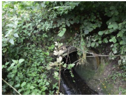
Afbeelding: Voorbeelden slechte beekstructuur: Nellebeek in betonnen kuip t.h.v. Lindaal (links) en start ingebuisd traject Nellebeek t.h.v. Kaalheide (rechts)
