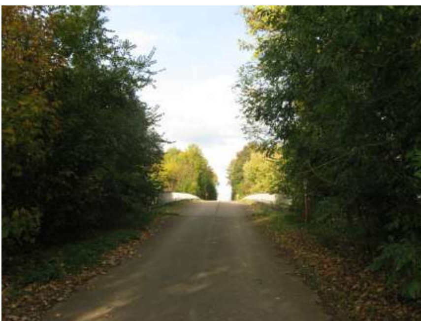
Foto's: Zicht op het brugdek (B.21) en de meerwaarde die via verdere omvorming kan worden gerealiseerd
