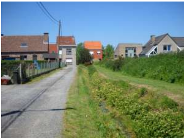
Foto: Zicht op het deel waar de gemeente Tervuren rioleringswerken plant
