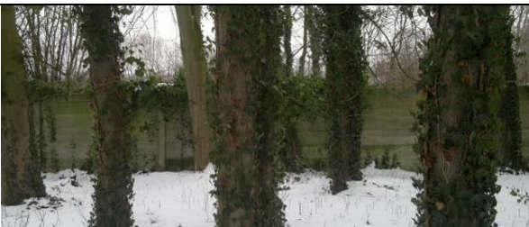
Te verwijderen betonnen afsluiting (1.1.2)
