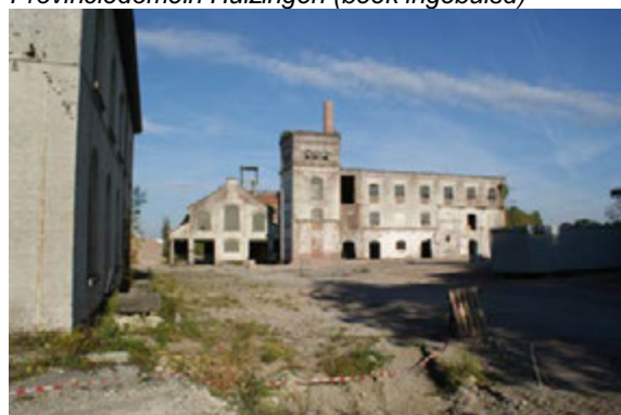
Project Neerdorp (beek ingebuisd)
