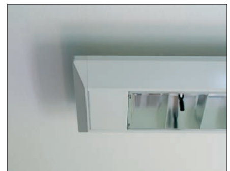
Daglichtsensor ingebouwd in de armatuur
