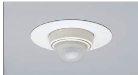
Afwezigheidsdetector ingebouwd in een vals plafond
