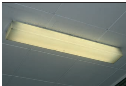
Armaturen met een melkglazen lichtkap
