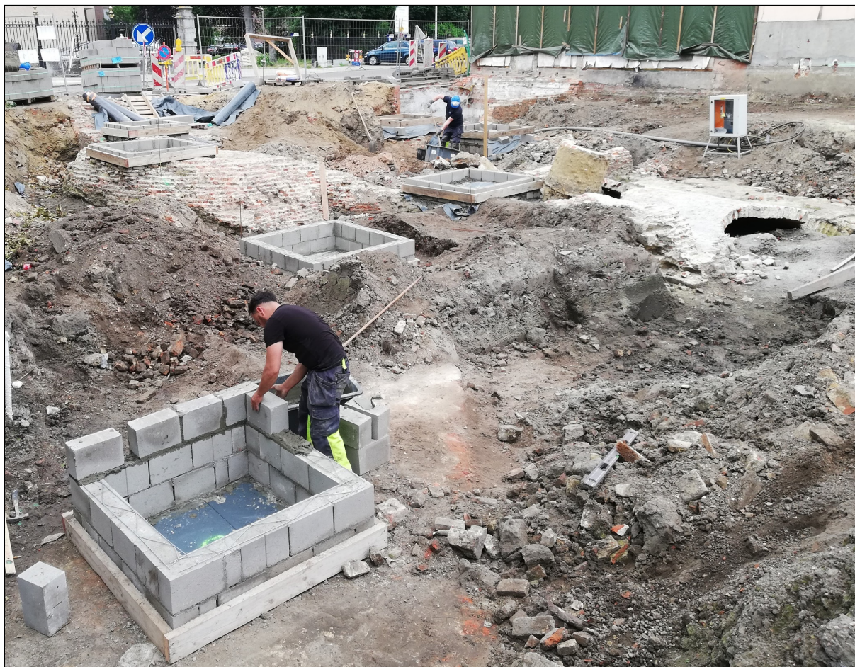
Fig. 39: Funderingspijlers voor de nieuwbouw werden rechtstreeks op de zware muurresten van het kasteel gebouwd met geotextiel als buffer (© Gillion Bouw).
