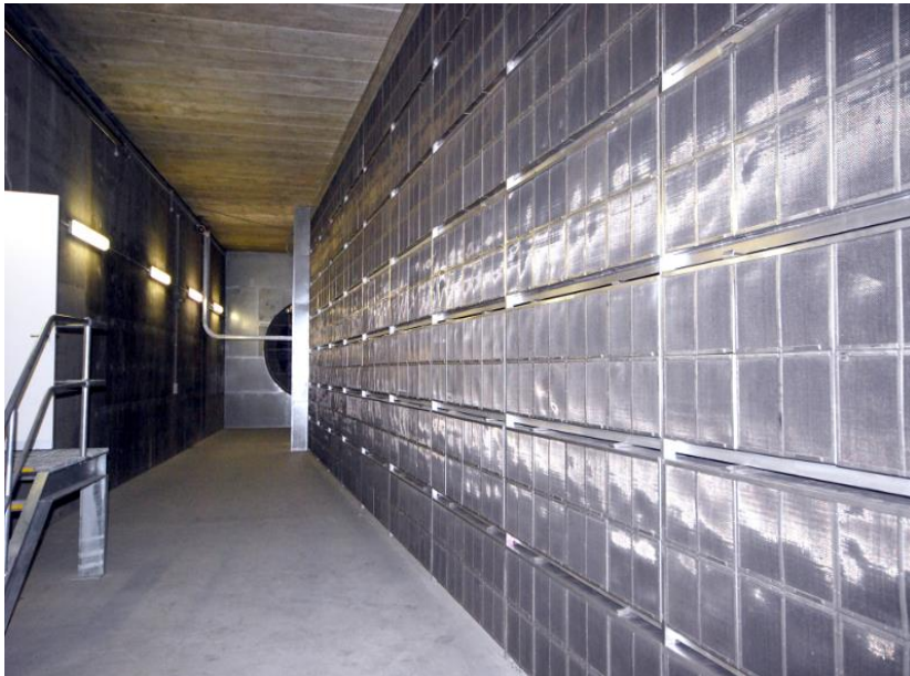
Figuur 3-27: Filterwand met modulaire actief koolfilters.
