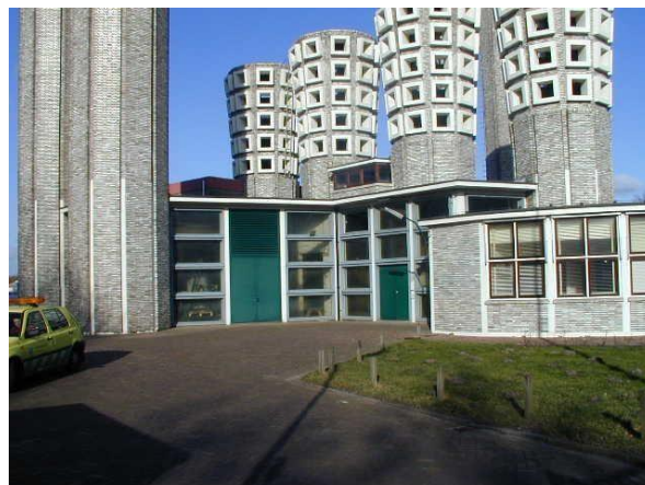
Figuur 3-15: Ventilatiertorens van de dwarsventilatie in de Velsertunnel in Nederland.
