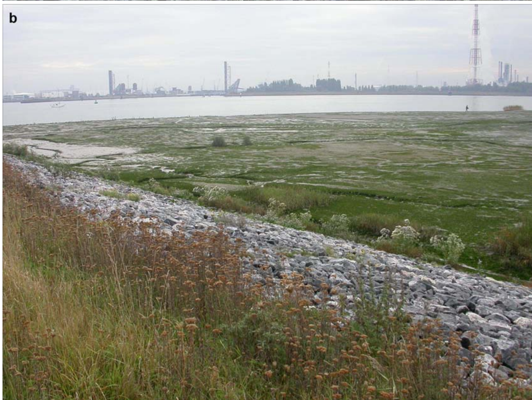
Figuur 4.5: Ketenisse schor ter hoogte van de e-raai: a. tijdens de werkzaamheden (april 2002) en b. na de herinrichting (oktober 2004).
