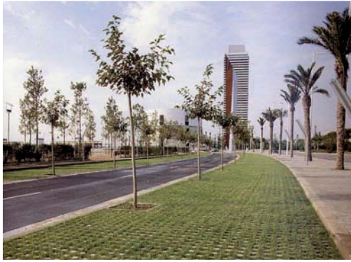
Figuur 30: Waterdoorlatende voegen – Kop van Zuid, Rotterdam
