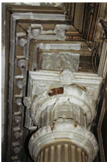
Alvorens grove restauratiewerken uit te voeren, werden fijn houtsnijwerk en vergulde siermotieven beschermd tegen verdere beschadigingen en stof door middel van opgelijmd chineespapier. Detail zuil gelijkvloers hoofdgebouw (foto W. Slock)
