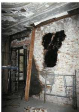
a. - b. Differentiële zetting en een oude schouwbrand zorgen voor problemen in het dragende metselwerk op het gelijkvloers, de 1 ste en 2 de verdieping (foto W. Slock)
