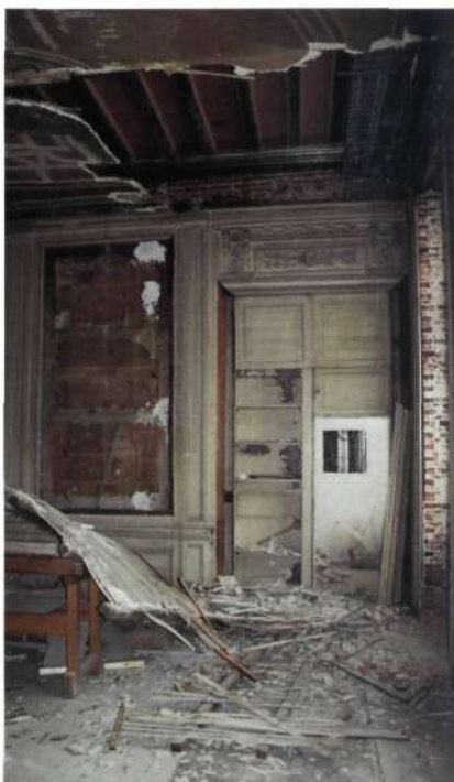
◀ De voormalige eetplaats op de 1 ste verdieping van het hoofdgebouw vóór de restauratiewerken (2 de fase). Een deel van het plafondstucwerk is losgekomen en neergestort. Op de wand ontbreekt de textielbekleding (foto W. Slock)
