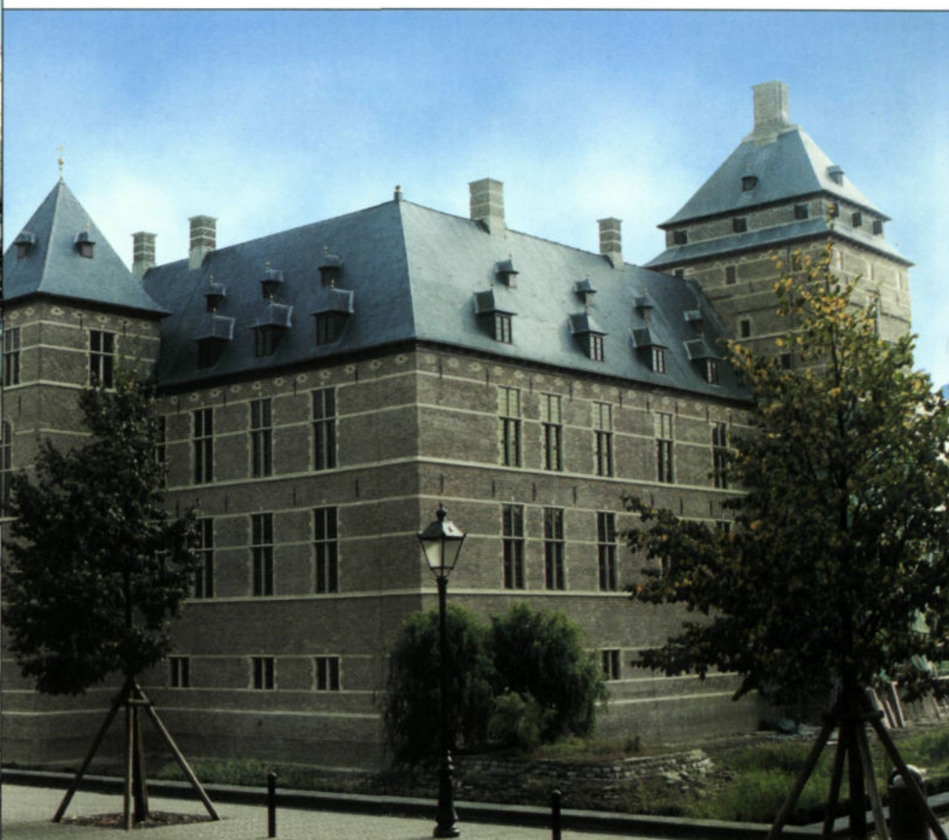
Restauratie buitengevels gerechtshof "Kasteel" van Turnhout
