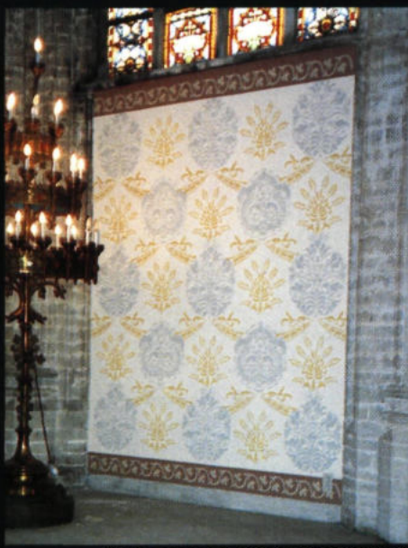
Vrijleggen en renovatie damastschilderwerk St. Martinuskerk - Overijse.
