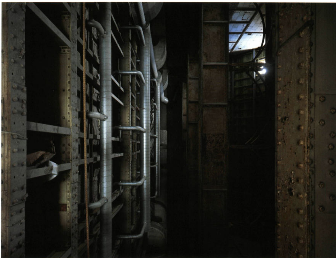
Geklinknagelde spanten boven de Theaterzaal (foto O. Pauwels)
