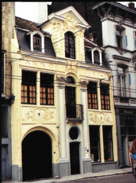
Restauratie gevel 18e eeuwse "Goubloome" - Gent.
