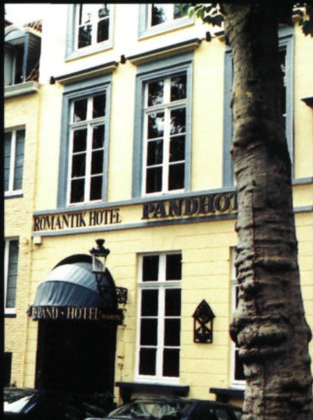
19e eeuwse gevelrestauratie en schilderwerk Pandhotel - Brugge.
