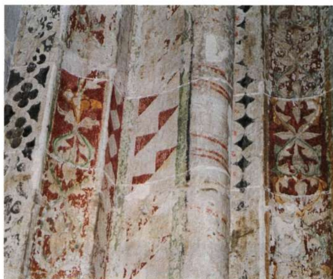
▼ Sondering naar de architectuurpoly- chromie in de kerk van Saint-Antoine- l'Abbaye in de Rhône-Alpes (foto P. Schurmans)
