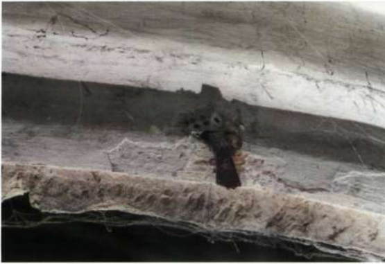
▲ Detail van de uitsparingen in de ribben en de metalen klemmen om de opdeling van de ruimte te realiseren (foto L. Van Dijk)
