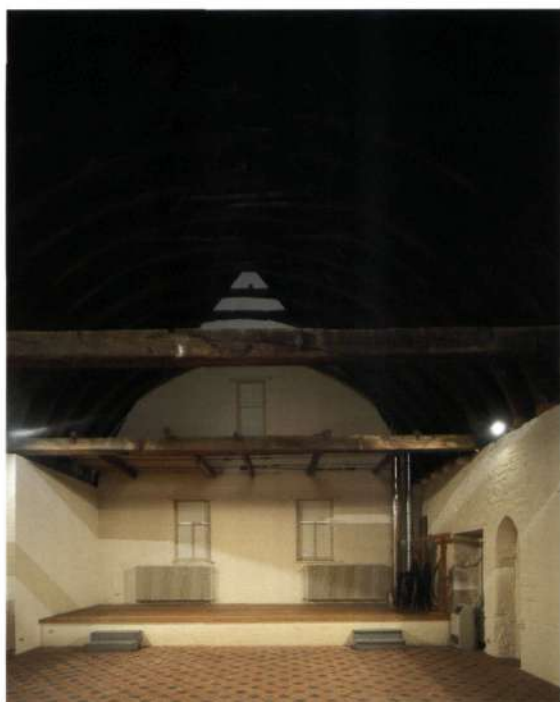
▲ Binnenzicht op het dormitorium (© THOC, juni 1999)
