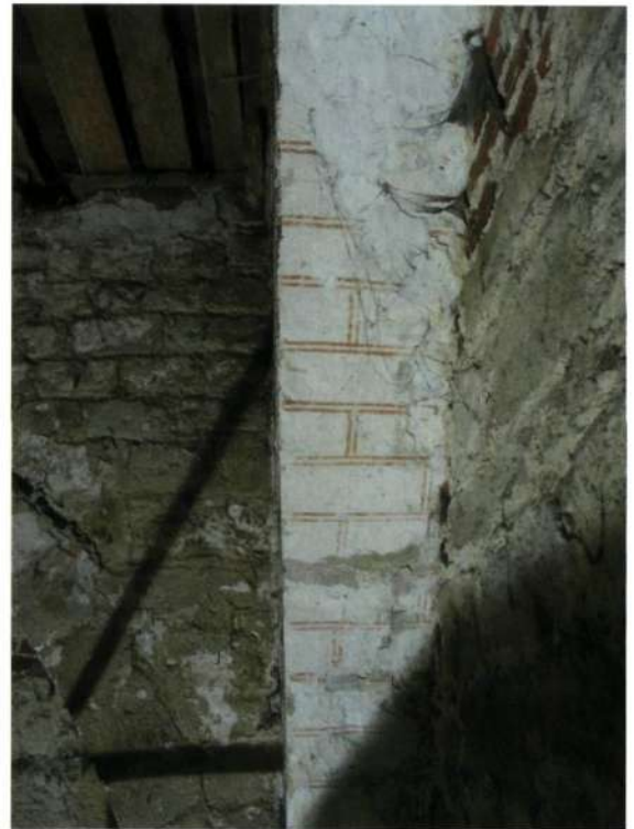
▲ Idem: detail van de boog met dubbele rode voegen op witte kalkonder- grond (foto P. Schurmans)
