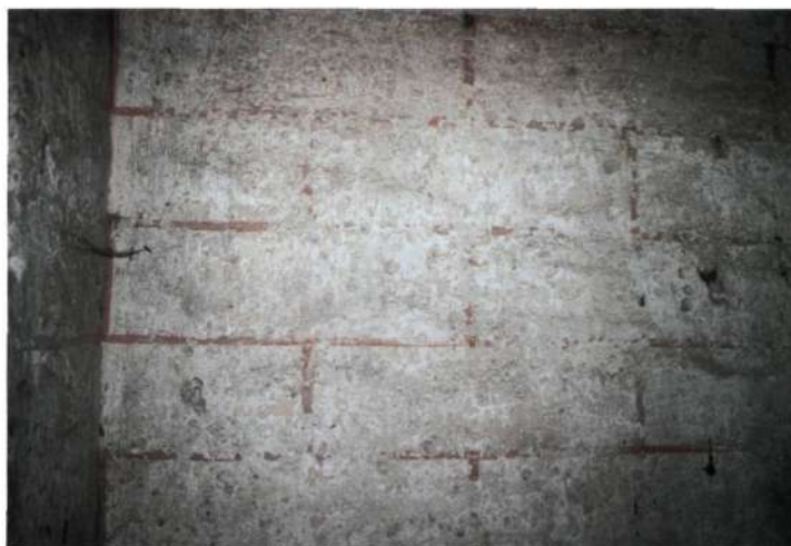
▲ Detail van de rode voegenschildering in het Landhuis van Veurne (foto C. Metdepenninghen)
