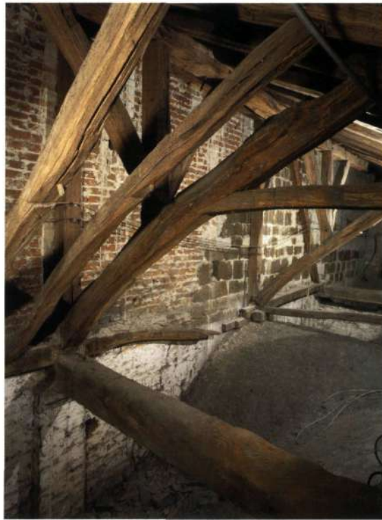
◀ Bouwnaad en materiaalgebruik duiden de overgang aan tussen de twee bouwfasen: muur van de middenbeuk boven de gewelven van de zuidelijke zijbeuk (foto Oswald Pauwels, 2001)
