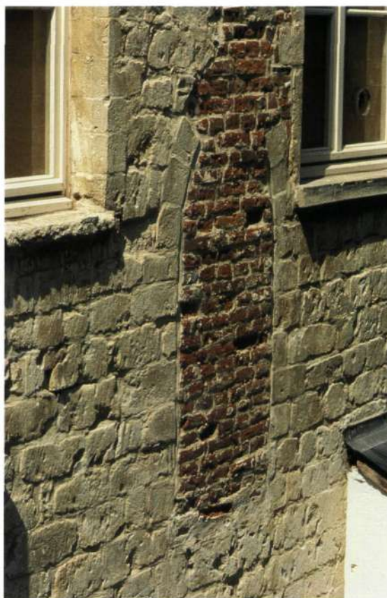
◀ Dichtgemetseld venster van het dormitorium (© THOC, juli 2004)
