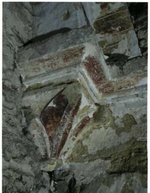
▼ Idem: detail van de console en de profielen met rode beschildering en de wit met rode stenen op de boog (foto P. Schurmans)
