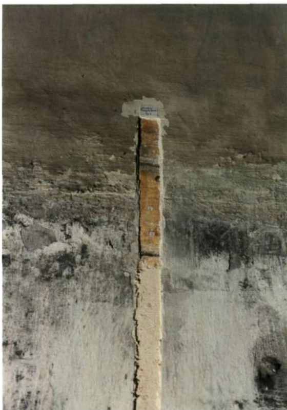
▲ Sonderingsproeven op de noordmuur tijdens het vooronderzoek van Linda Van Dijck en Louis Dekoninck (foto L. Van Dijck)
