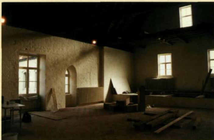
◀ De oostvleugel tijdens de restauratie (foto M. Buyle)
