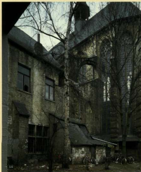
▼ De Predikherenkerk gezien vanuit het oosten, vóór de restauratie (foto O. Pauwels)
