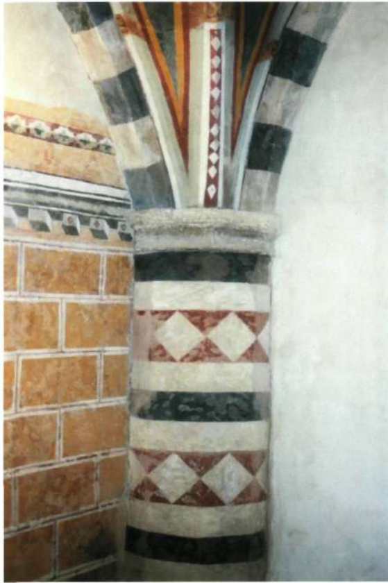
▲ Architectuurpolychromie in het Casa Corboli in Asciano met voegenimitatie en ribbenversieringen (foto M. Buyle)
