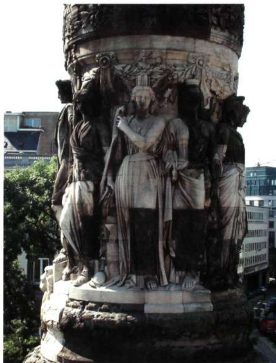
▲ De Allegorie van de Provinciën en de Genius van de Koninklijke Macht, door Eugène Simonis (1810-1882), zuidzijde vóór restauratie. De herstellingen in Euvillesteen zijn duidelijk herkenbaar (foto Regie der Gebouwen, 2000)
