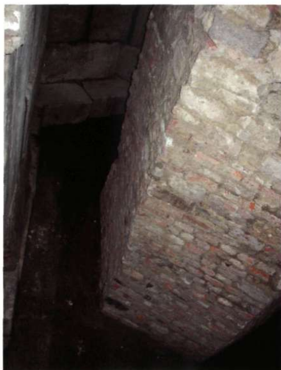
▼ Binnenin de sokkel, met bovengrondse bakstenen fundering van de obelisk (foto BOA)
