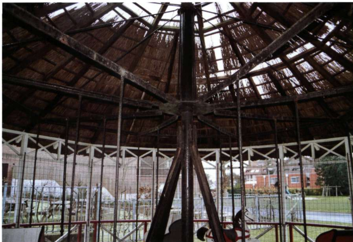
◀ Zicht op de ijzeren constructie en de dakstructuur die nog deels met stro bedekt was in 2002 (foto AML)
