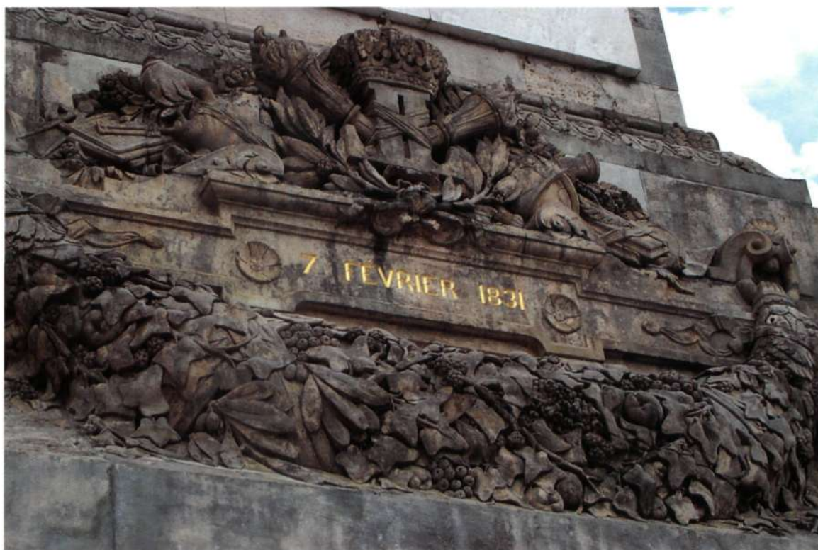
Westzijde van het middelste derde van de sokkel, voor restauratie (foto Regie der Gebouwen, 2000)
