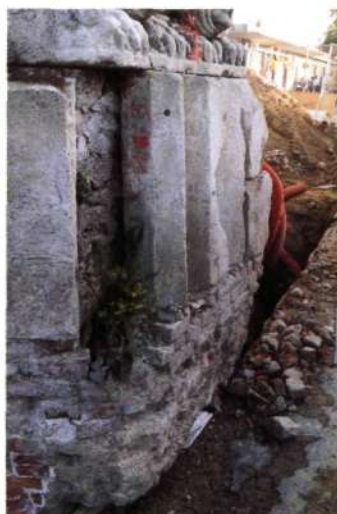
▼ Een fonteinbekken steunt op de recuperatiefundering van het verplaatste monument voor Van de Weyer (foto BOA)
