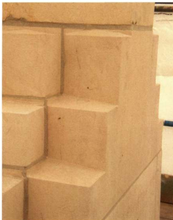
► Aangepaste detailering van de horizontale voegen aan de top van het monument (foto BOA)
