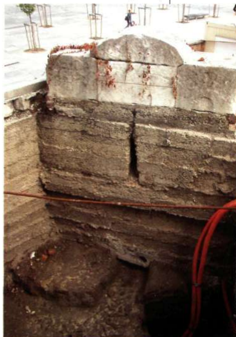
▼ Originele steunmuren in ongewapend beton voor de bastionsokkel (foto BOA)
