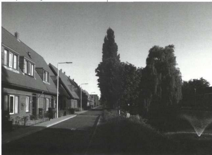
Zicht op de nieuw gebouwde huizen
