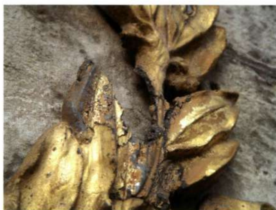
▲▲ Een bestaande, beschadigde blader- krans (eik en lau- rier) uit zamac (foto Regie der Gebouwen)
