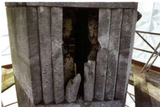
◀ Opbouw van de obelisk: stortbeton tussen de bakstenen structuur en de buitenbekleding in natuursteen (foto nv Building)
