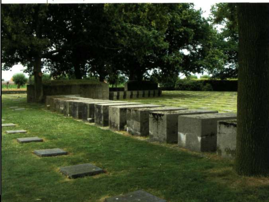
▼ Duitse betonnen constructies op de Duitse militaire begraafplaats van Langemark (foto O. Pauwels)
