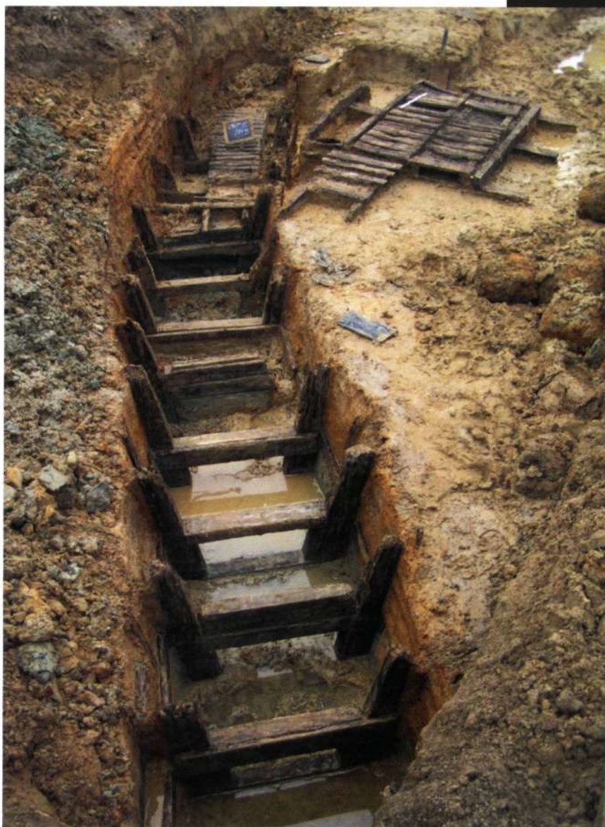
▲ Boezinge, Helm Trench. In de strijd tegen het grondwater had men de A-frames moeten aanpassen / verhogen
