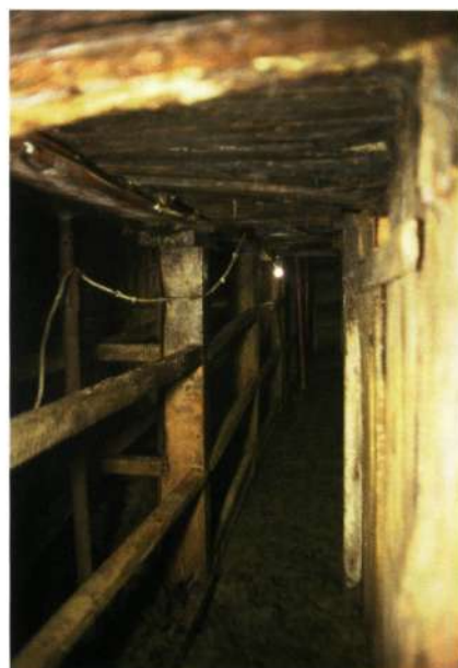
► Zonnebeke, Bremen Redoubt. Houten geraamte van de ondergrondse slaapplek (3 x 2 soldaten naast mekaar)
