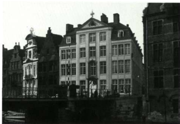
Restauratie: 'De Vijfsterren' Gent
