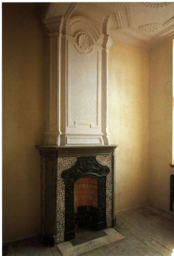
Schouwgeheel in het lokaal achter- aan links op de eerste verdieping. Toestand na de restauratie (foto O. Pauwels)
