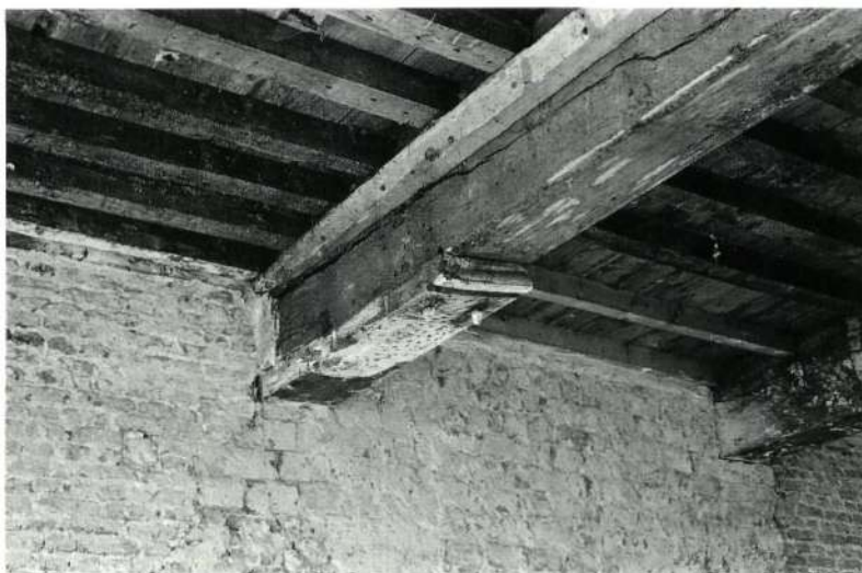
Balksleutel met eenvoudig peer- kraalprofiel in huis 1 (eigen foto)
