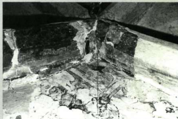
De kruising van de ribben in gewelfvlak A-B na voorlopige vrijlegging in december 1980 (foto M. Hendrickx)
