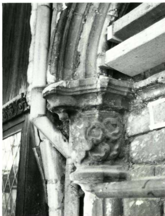
Het Paradijs, detail van de gevel voor restauratie. De korbogige ontlastingsbogen rusten op een console, versierd met bladwerk en een wapenschild. De smeedijzeren dook verwijst naar een verdwenen decoratief beeldhouwd element.
