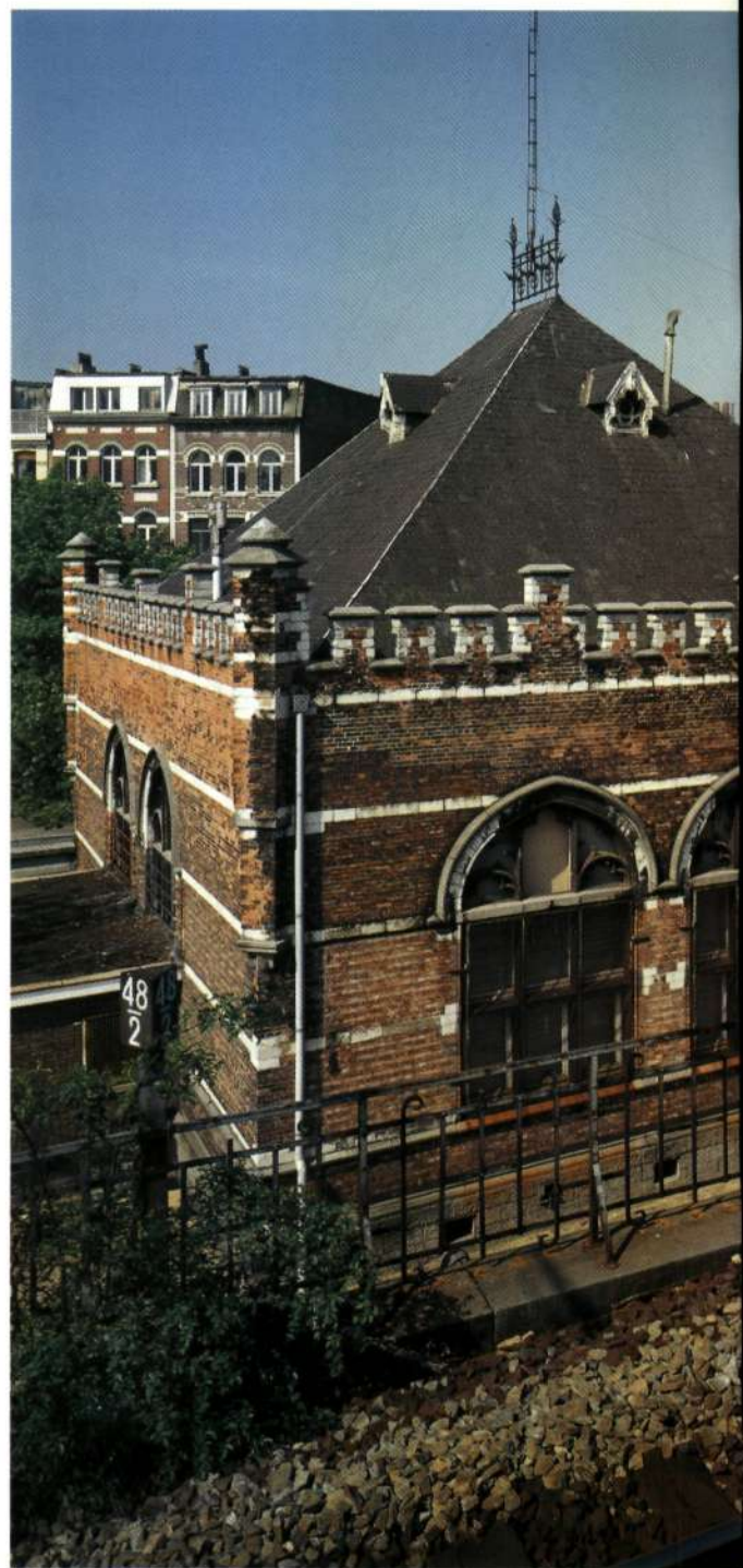
33. Auteurs - Déplacement et exhaussement de la Gare du Dam, exécutés par MM. MORGLIA & WILLES, Ingénieurs. Van vers les voers d'après le déplacement. Le bâtiment est déjà déplacé de 3 m.
