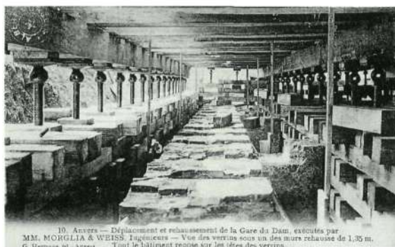
11. Anvers — Déplacement et exhaussement de la Gare du Dam, exécutés par MM. MORGLIA & WEISS, Ingénieurs. Les deux MM. MORGLIA & WEISS qui ont exécuté G. Hermans, éd., Anvers. Les travaux.
