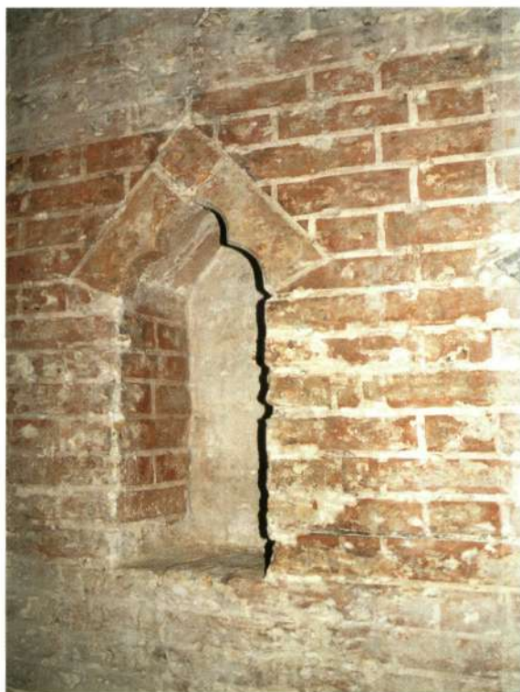
Gotische lampnis met baksteen- imitatieschildering in de kamer op de eerste verdieping (foto M. Buyle)
