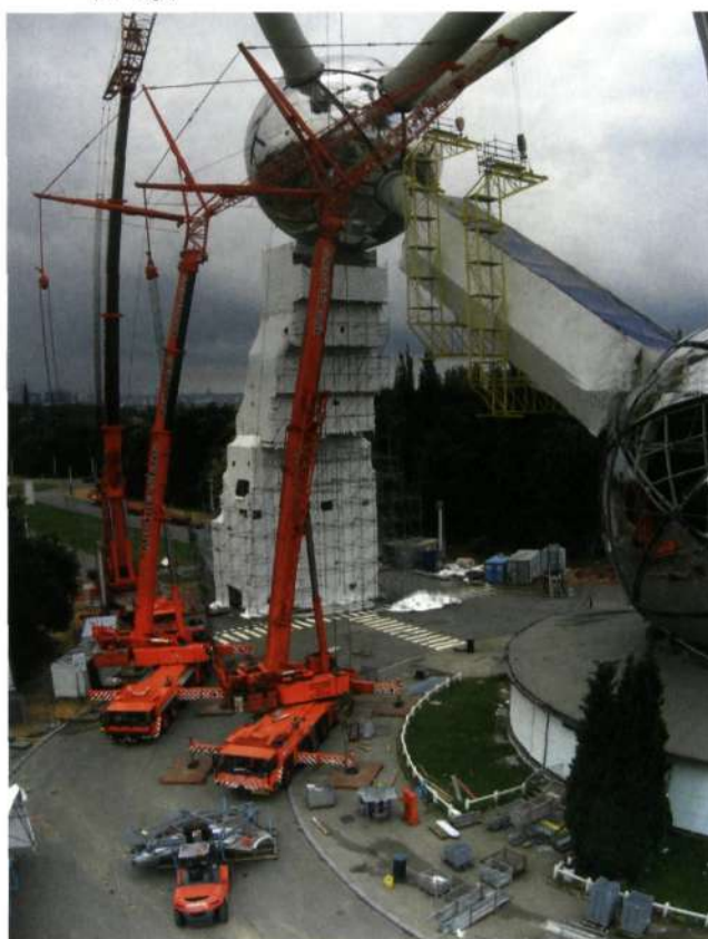
▼ Werfinstallatie voor montage van de geprefabriceerde panelen (foto Origin)
