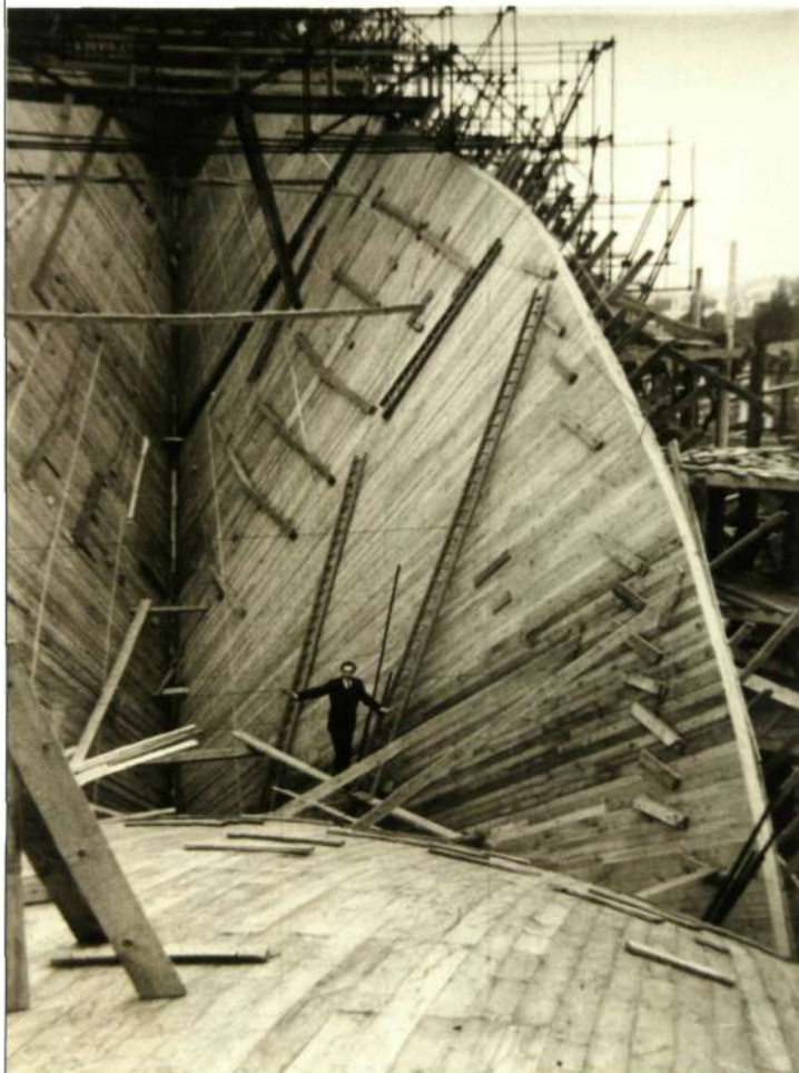
▼ De bouw van de Pijl (© AAM)
