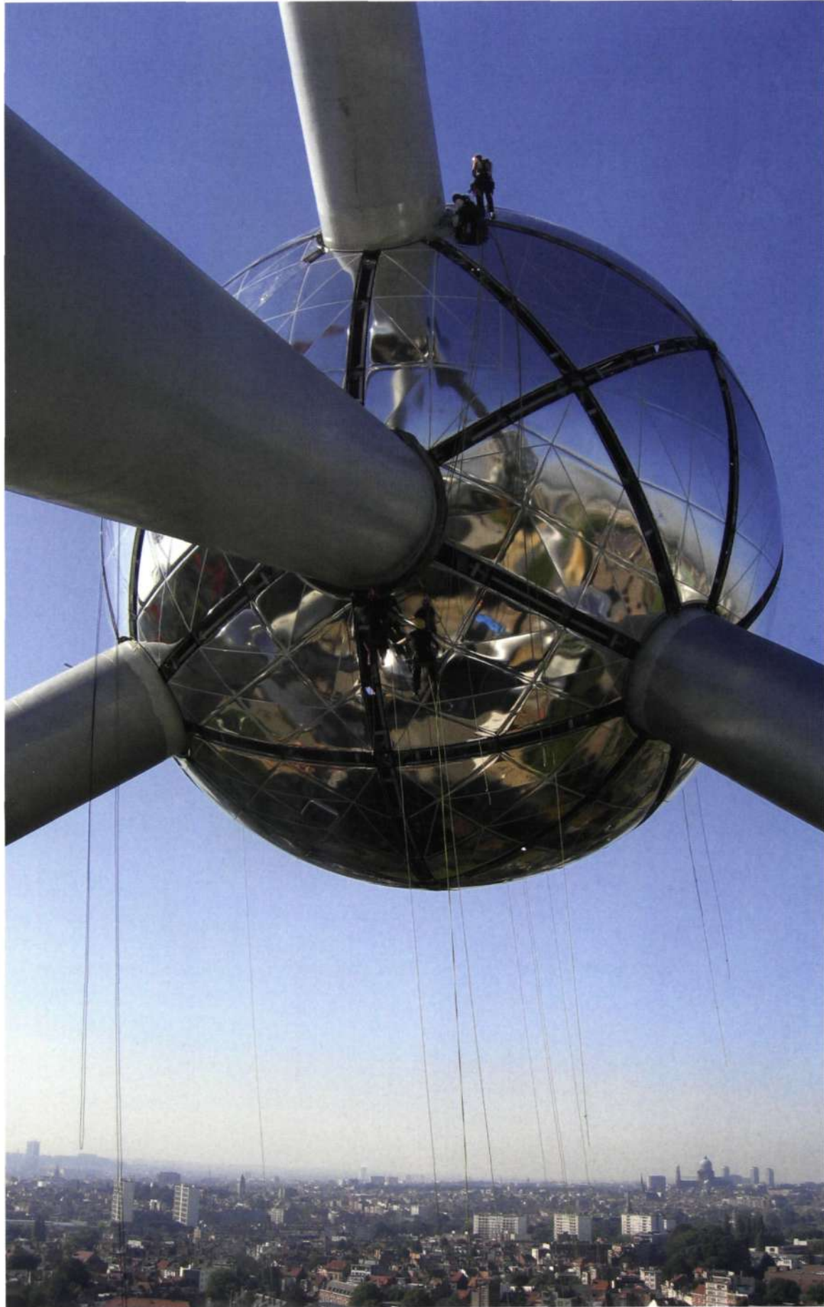
◀ Buitenzicht M-bol vóór de plaatsing van de meridianen (foto Origin)
