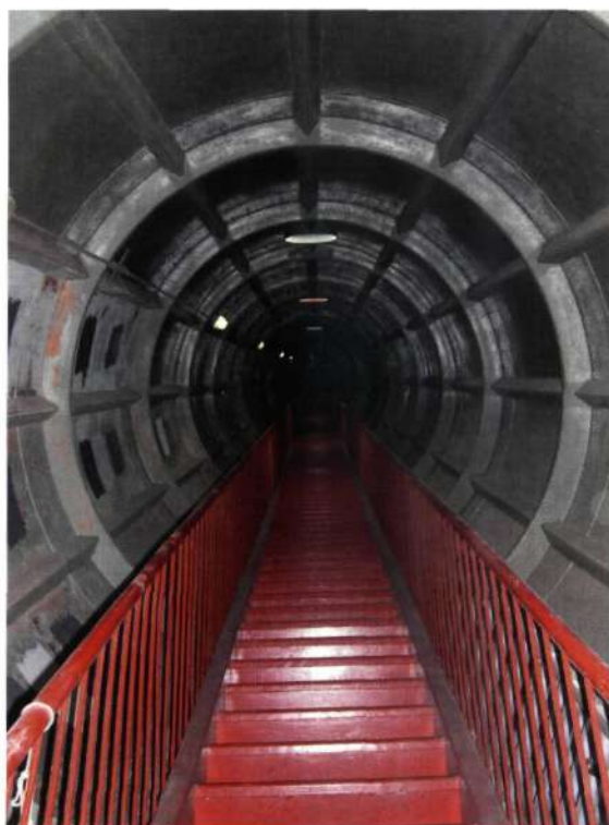
▲ Trap in buis M-II als bijkomende noodtrap voor de brandveiligheid (foto Origin)
