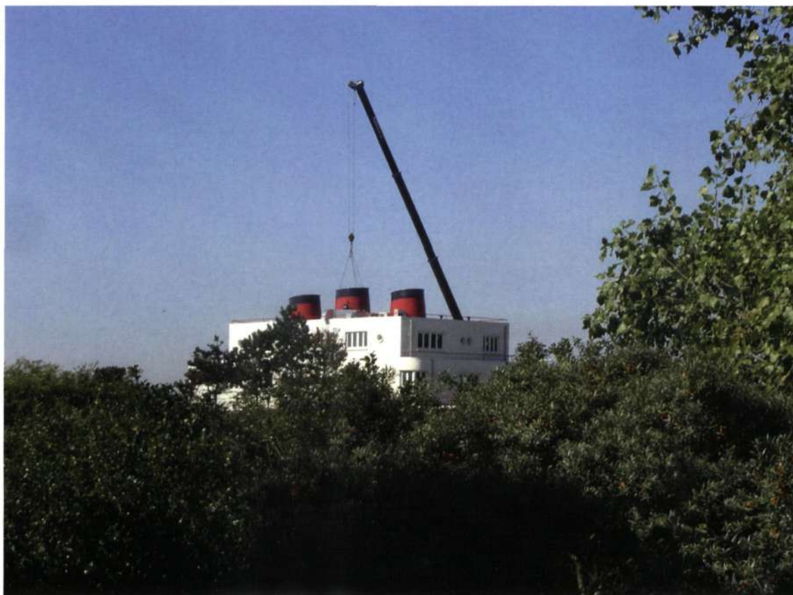
De drie nieuwe aluminium schouwen werden met een grote kraan op het dak geplaatst (foto arch. Vandendries)
