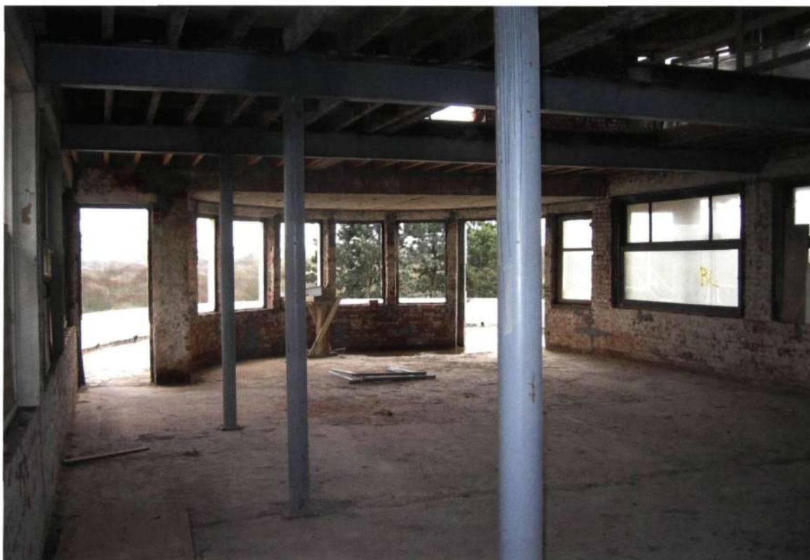
◀ Binnenin werd een nieuwe staalconstructie geplaatst ter ondersteuning van de oorspronkelijke structuur (foto arch. Vandendries)
