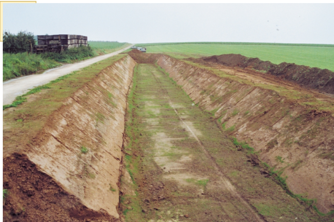
Bufferbekkentje in aanleg (Gingelom).
