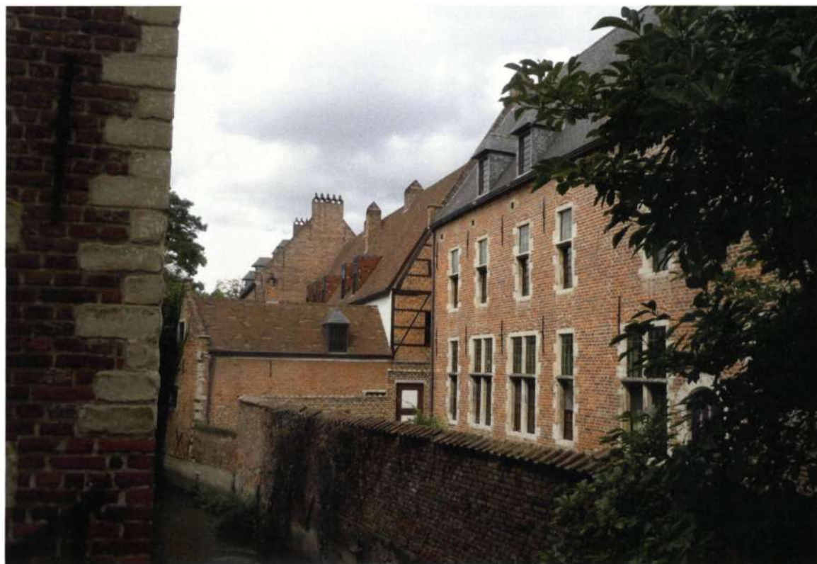
◀ Ondermeer geres- taureerde kruis-en kloosterkozijnen in de achtergevel van het Huis nr. 50 aan de Kleine Dijle (foto auteur)
