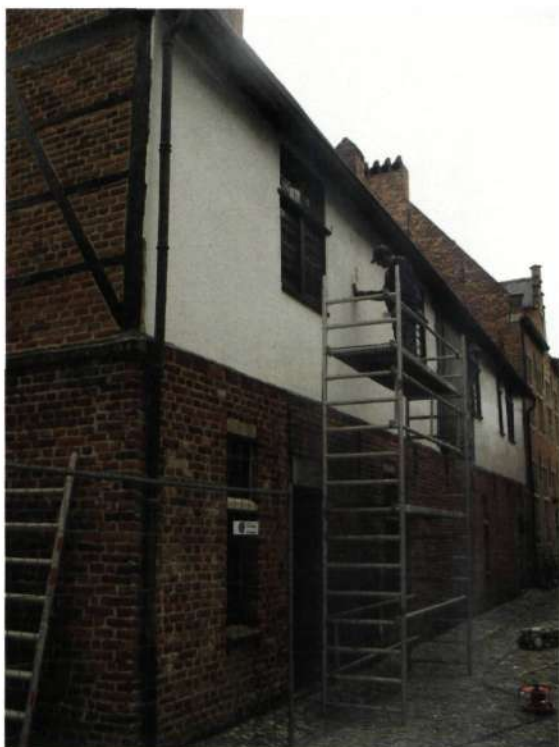
Behandeling van het geleemde vakwerk in de bovenpartij van het huis
