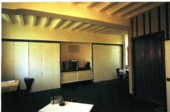
► Flat in Huis nr. 83. Ingebouwde kasten en zoldering met troggewelfjes (archiefoto RL-BE-130-1271)
