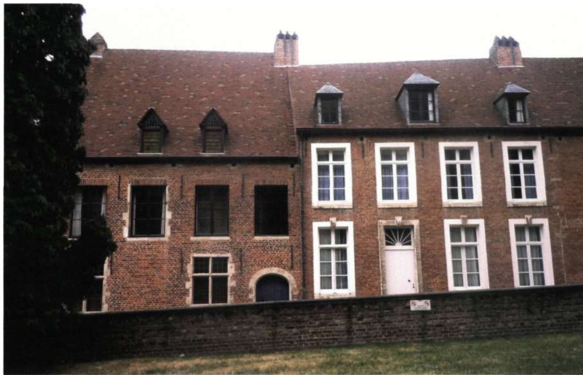
◀ Verschiedene vensters en ramen: gerestaureerd 17 de -eeuws kruiskozijn met glas-in-lood en 19 de - (nr. 73) en 18 de -eeuwse (nr. 74) ramen met grote roede-verdeling (foto SVA-VH)
