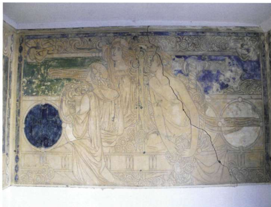
Overzichtsfoto van het grote sgraffito op het terras na de verwijdering van de overschilderingen maar vóór de reiniging en de opvulling van de lacunes. De blauwe overschildering van het kruis is nog aanwezig (foto M.-H. Ghisdal)
