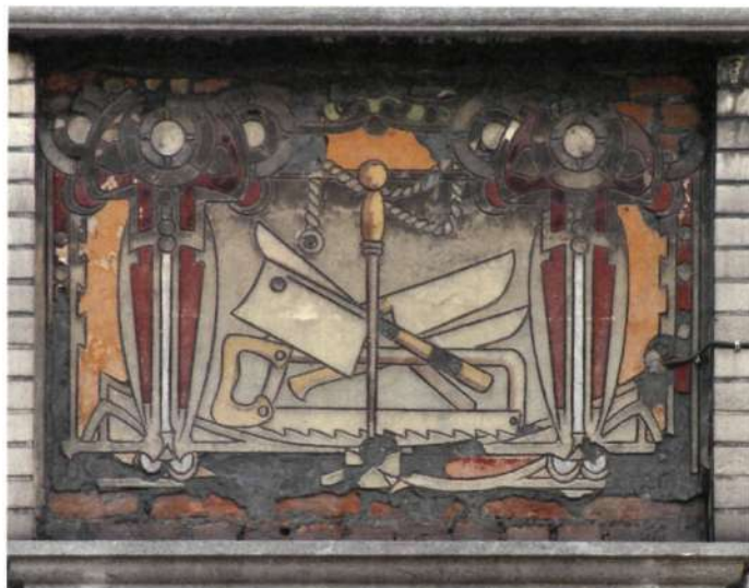
De voormalige runds- en varkensbeenhouterij aan de Cobdenstraat in Antwerpen (foto's O. Pauwels)
