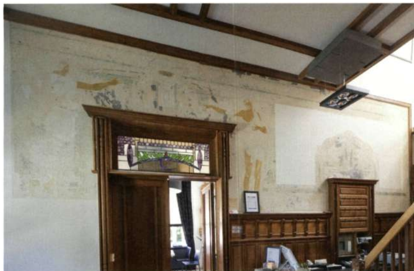
Het sgraffito van de oostwand werd beschadigd door ondeskundig blootleggen (foto O. Pauwels)
