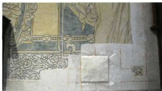
Tijdens de blootlegging met compressen (foto E. De Boer)
