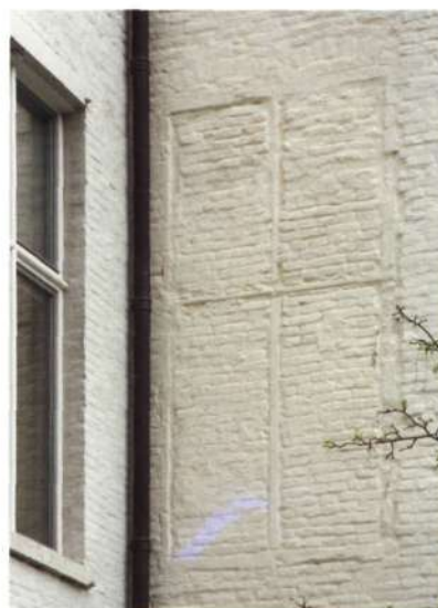
Sporen van een dichtgemetseld kruisvenster in de achtergevel (foto O. Pauwels 2012)
