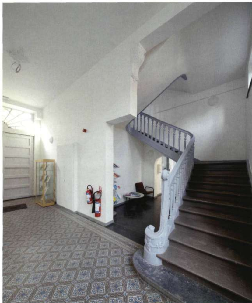
Interieur van de inkomhal: bij de restauratie zijn de weinige historische interieurelementen behouden: de cementen tegelvloer, de trap met barokke trappaal
