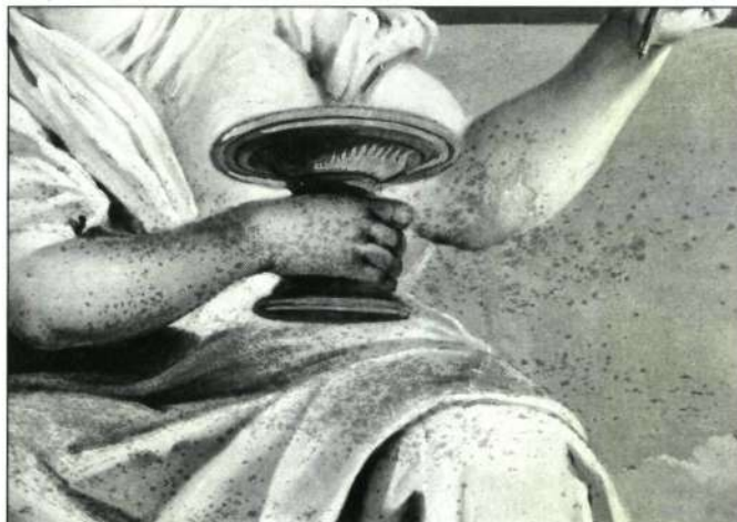
Gent, Hotel D'Hane-Steenhuysse. Schimmelvorming op de muurschildering ten gevolge van vochtig klimaat (foto B.M.L.)
