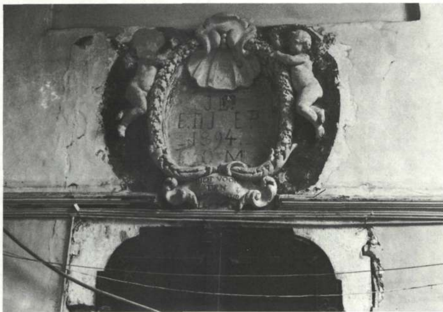
Antwerpen, Godshuis Landschot aan de Falconrui, cartouche (17de eeuw) met putti na het verwijderen van de talloze kalklagen. Het geheel was in steenkleur (lichtgrijs) geschilderd, met een zwarte schaduw-schildering errond. Bemerkt ook de interessante hardstenen deuromlijsting.
