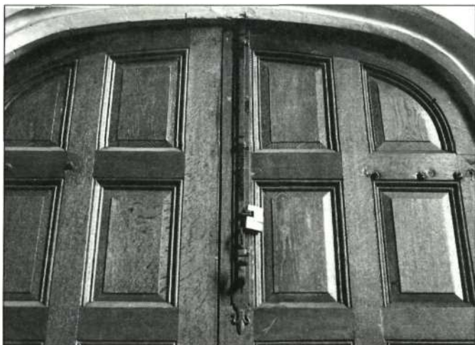
Voorbeeld van mechanische beveiliging : staartschuif (foto B.M.L.)
