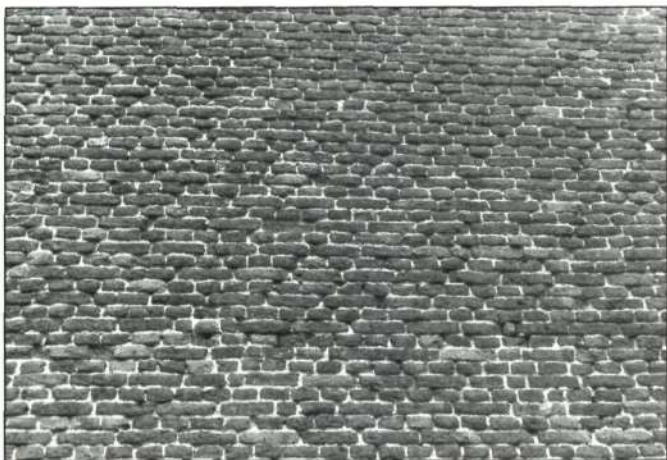
Toestand metselwerk mei 1984 (zijgevel). Bij de bouw werd een veldovensteen gebruikt van minderwaardige kwaliteit die sterk onderhevig is aan weersinvloeden. Aangezien de voorgevel gekalkt was, werd bij de restauratie de voorgevel na reiniging gekaleid met een verdunde metselspecie. Zodoende konden vervangingen tot een minimum worden herleid. Hierop werd geschilderd. De zijgevels werden plaatselijk hersteld en hervoegd daar geen enkel spoor er op wees dat zij ooit afgewerkt werden (foto B.M.L.).
