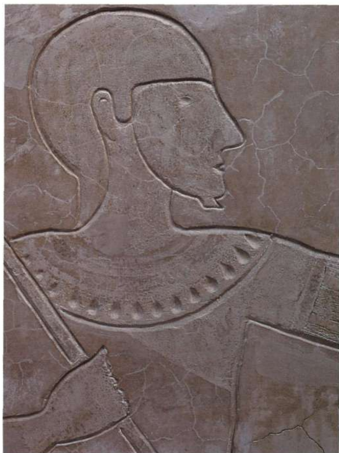
Bovenste register van de linker pyloon. De barstvorming (windscheuring) is duidelijk gebonden aan de kleurzones (foto J. Luyten)
