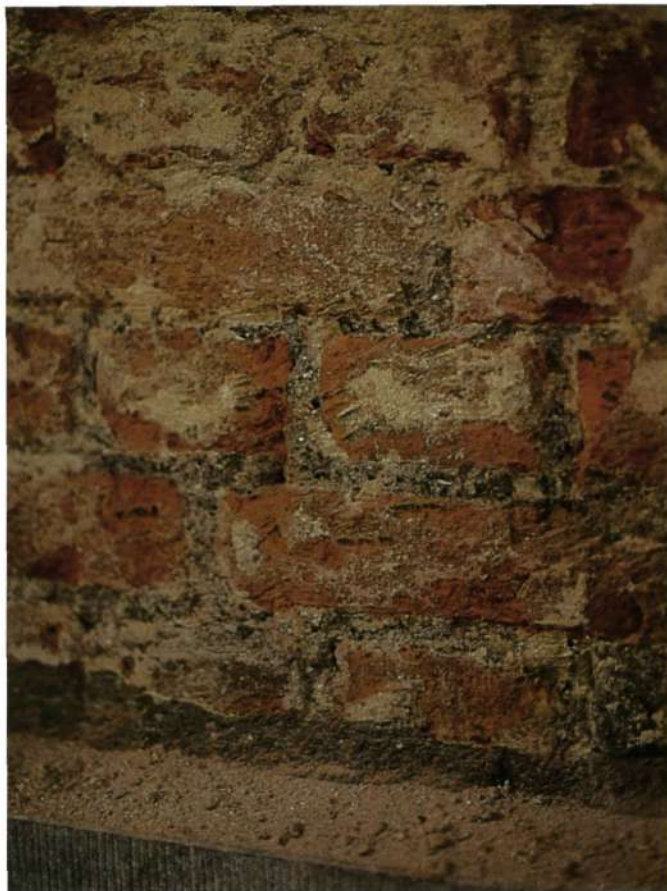
Rechter binnenwand van het voorportaal. De onderste drie baksteenlagen waren opgemetseld met een grove trasmortel (eigen foto)
