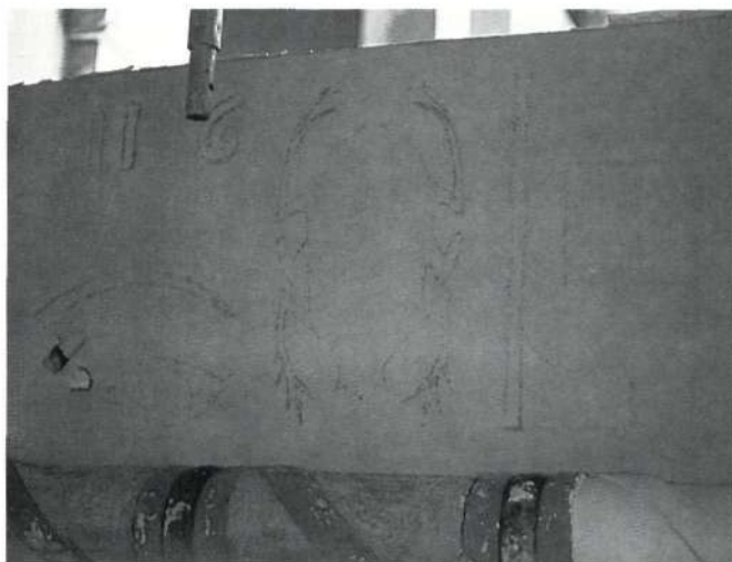
Binnenfries. Voortekening van de te reconstrueren graffito (eigen foto)
