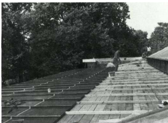
Boven: De nieuwe lichtkoepel in aluminiumprofielen wordt gemonteerd (foto B.M.L.)
