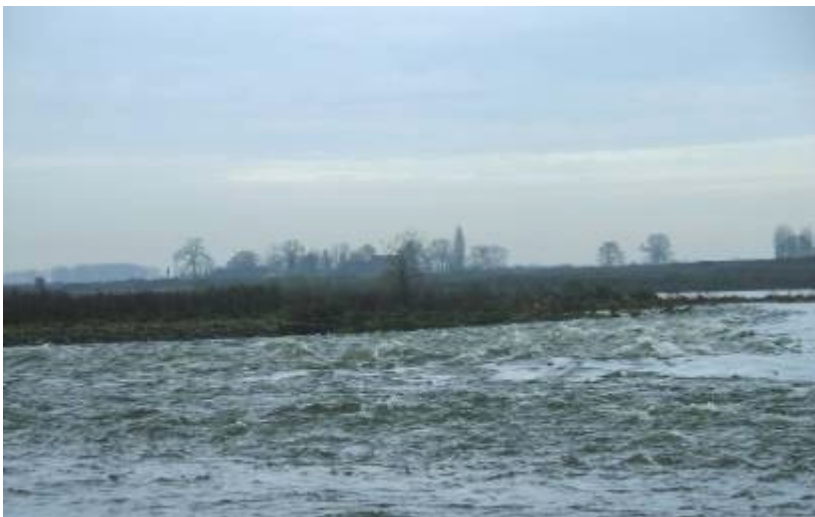
Beeld van de hoge stroomsnelheden over drempel 1 (opname bij zomerafvoer van 80m³/s).
