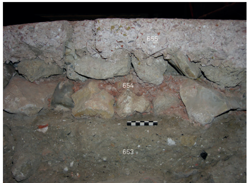
FIG. 1.19 Tongeren: O.L.V.-basiliek: werkput 16 in de middenbeuk en de viering: detailopname van de sporen 654 en 655. Het losse dakpangruis en mortelgruis van spoor 654 kan verkeerdelijk als een oudere betonvloer geïnterpreteerd worden. In werkelijkheid gaat het om verkruimelde uitgeharde mortel en dakpangruis dat als funderingsmateriaal voor spoor 655, wel een gegoten betonvloer, gebruikt werd.
