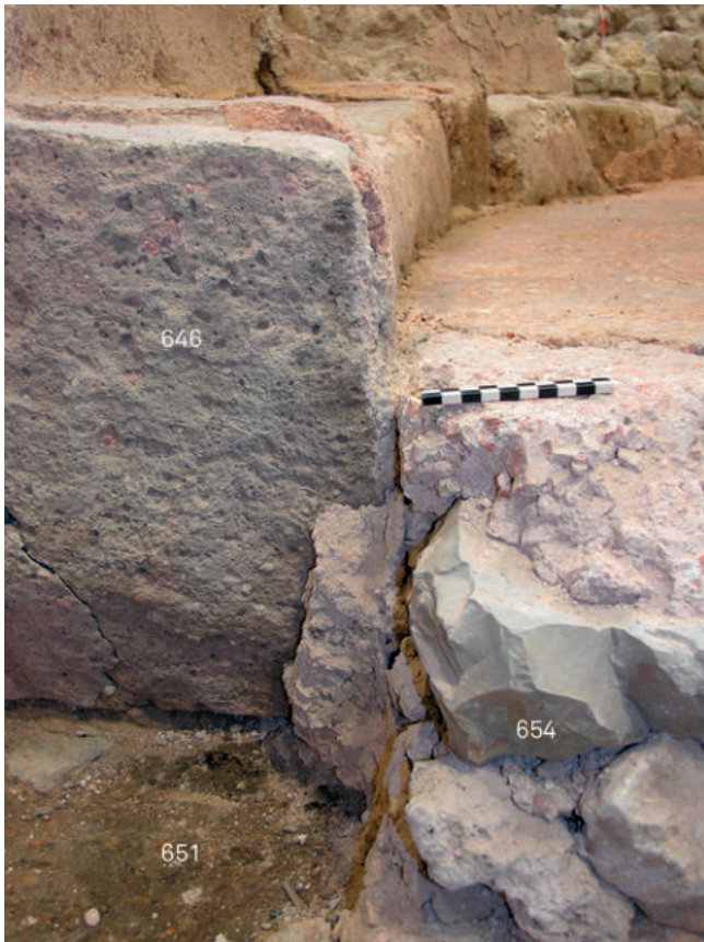
FIG. 1.16 Tongeren: O.L.V.-basiliek: werkput 16 in de middenbeuk en de viering: detailopname van de relatie tussen spoor 646 en 654-655 vanuit het noorden. De op de stenen bank 646 bewaarde bepleistering is voor het aanleggen van betonvloer 654-655 aangebracht.
