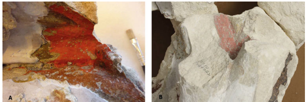
FIG. 4.97 Tongeren: O.L.V.-basiliek: open maaswerk met rood, oker, bruin en zwart decoratieschema: blootleggen van de oorspronkelijke afwerkingslagen (A & B).
