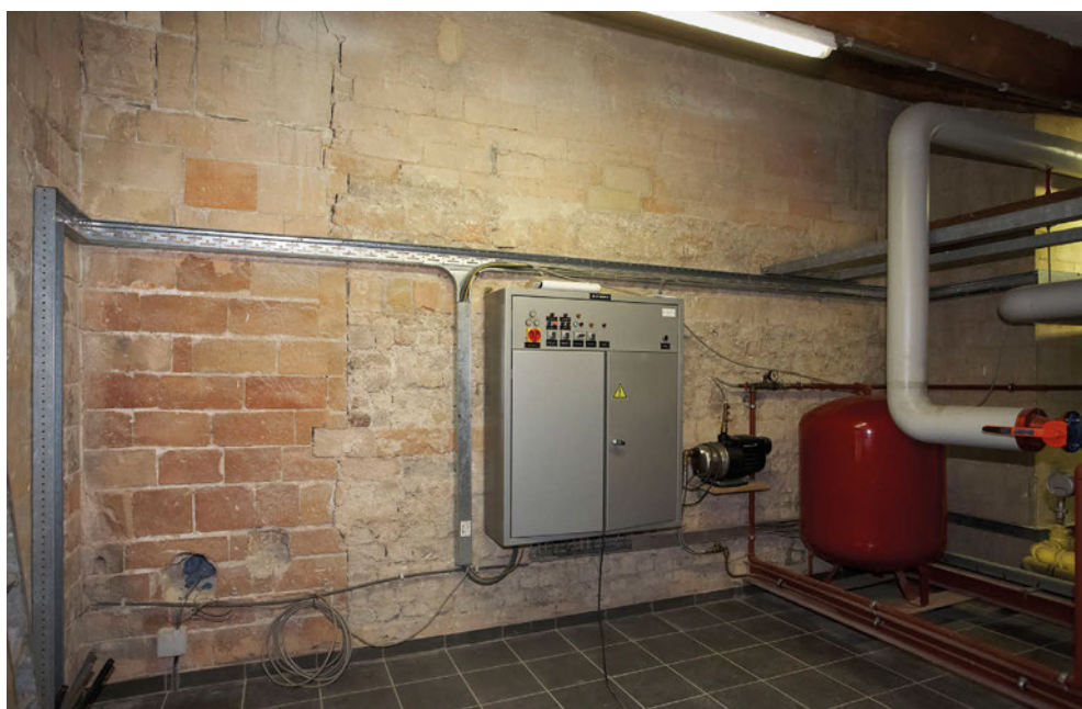
FIG. 2.15 Tongeren: O.L.V.-basiliek: noordmuur van de twee westelijke traveeën van het koor, ter hoogte van de zolder van de noordsacristie. Links tekent zich een bouwnaad af.
