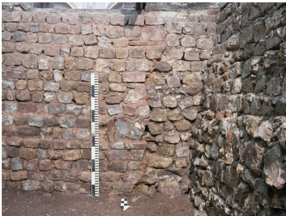
FIG. 2.19 Tongeren: O.L.V.-basiliek: de fundering van de laatste rechte koortravee (links), aangebouwd tegen de fundering van het eerste koorontwerp (rechts).
