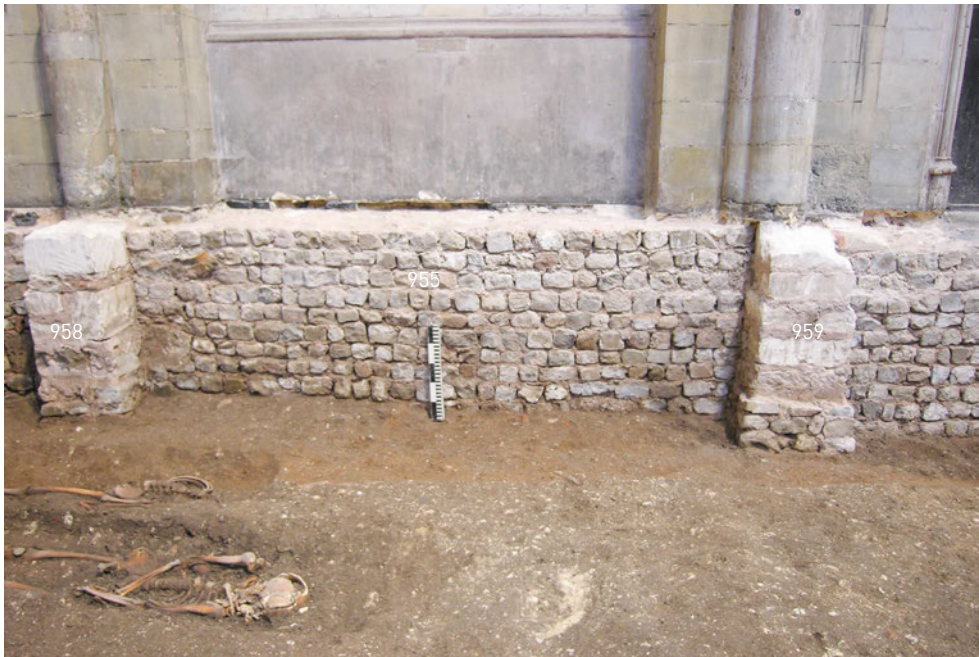
FIG. 1.99 Tongeren: O.L.V.-basiliek: werkput 27: sporen 955, 958 en 959 vanuit het noorden.
