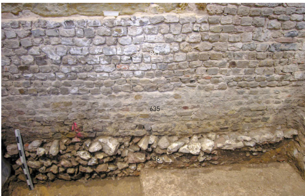
FIG. 1.22 Tongeren: O.L.V.-basiliek: werkput 17: spoor 861 vanuit het zuiden ter hoogte van de eerste noordelijke zijkapel (kapel van O.L.V. Onbevleete Ontvangeris).
