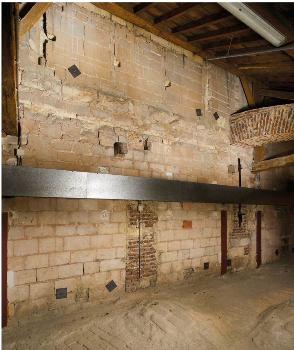
FIG. 2.37 Tongeren: O.L.V.-basiliek: zicht onder het lessenaarsdak van de noordelijke zijbeuk. De twee geprofileerde kraagstenen boven de nutsleidingen (metalen goot) droegen de kap van het oorspronkelijke lessenaarsdak. Het metselwerk daarboven is de opvulling van een bovenlicht, ten gevolge van de aanpassing van het lessenaarsdak. De bakstenen luchtbogen werden gebouwd in 1677-1680, samen met de herbouw van de kap na de brand van 1677.
