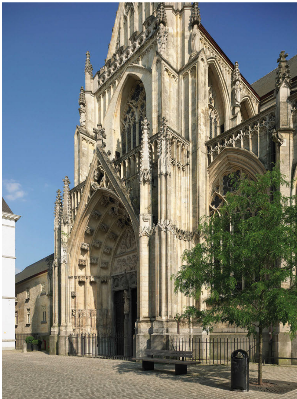
FIG. 2.44 Tongeren: O.L.V.-basiliek: het noordtransept gezien vanuit het noordwesten.
