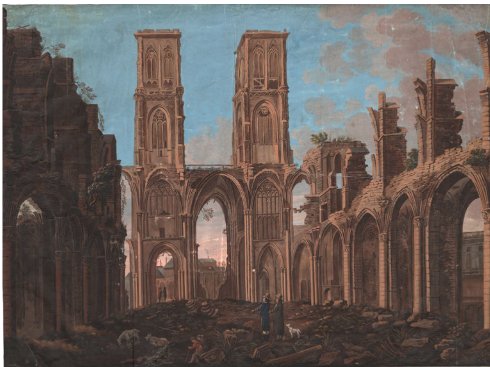
FIG. 2.47 De ruïnes van de Sint-Lambertuskathedraal in Luik, gezien naar het westen (J.G. Tahan, Vue des Ruines de la Cathédrale de Liège , 1802). In de westmuur van het westtransept lopen de stijlen van het triforium door in het maaswerk van de bovenlichten (© Université de Liège – Musée Wittert).
