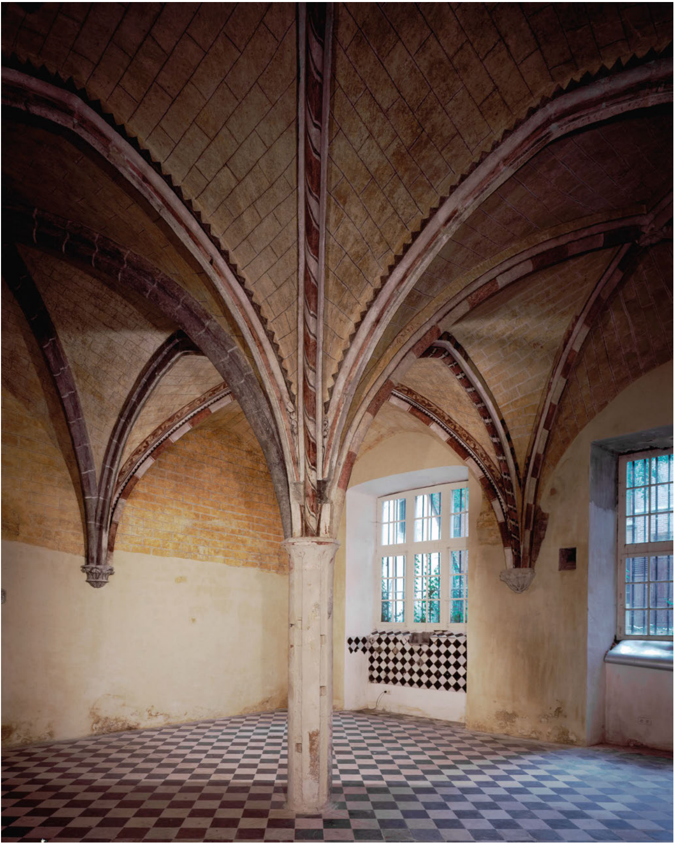
FIG. 6.4 Een bijna volledig ensemble van gotische architectuurpolychromie, met steenschildering op de muurvlakken, gecombineerd met kleurige motieven op architectuuronderdelen zoals de ribben en gewelvsleutels, in de voormalige sacristie van de Onze-Lieve-Vrouw-ter-Predikherenkerk in Leuven (foto O. Pauwels).
