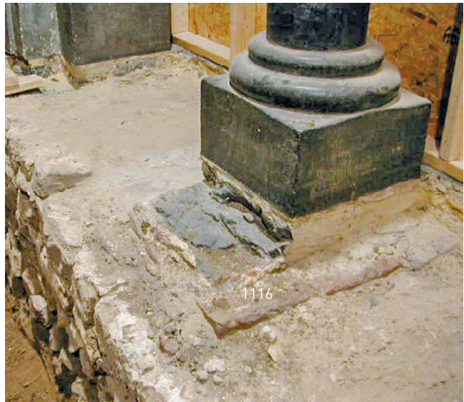
FIG. 1.182 Tongeren: O.L.V.-basiliek: werkput 11: spoor 1116 vanuit het noordwesten.
