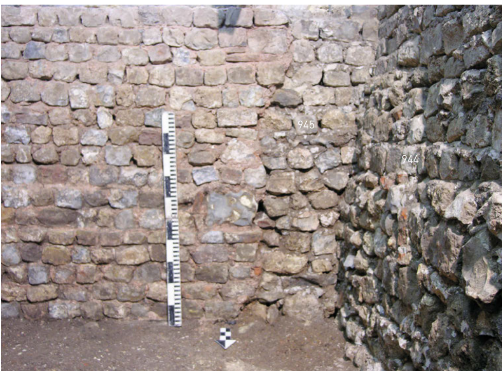
FIG. 1.89 Tongeren: O.L.V.-basiliek: werkput 29: noordelijke zijde van spoor 945 vanuit het noorden.
