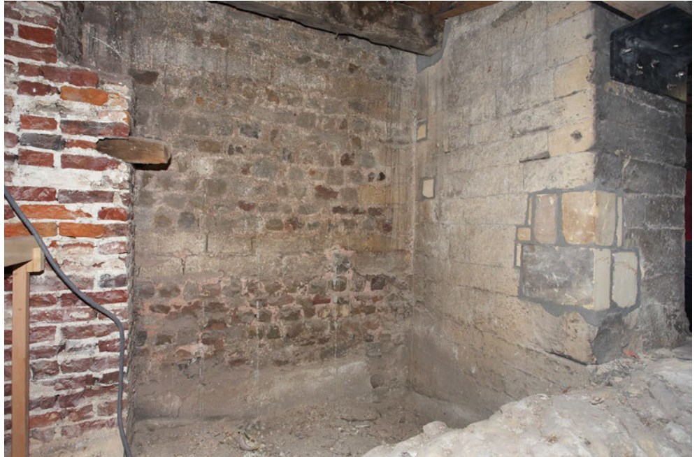
FIG. 2.8 Tongeren: O.L.V.-basiliek: oostwand van de onderste geleding van het zuidtransept, met metselwerk in Romeinse zandsteen.
