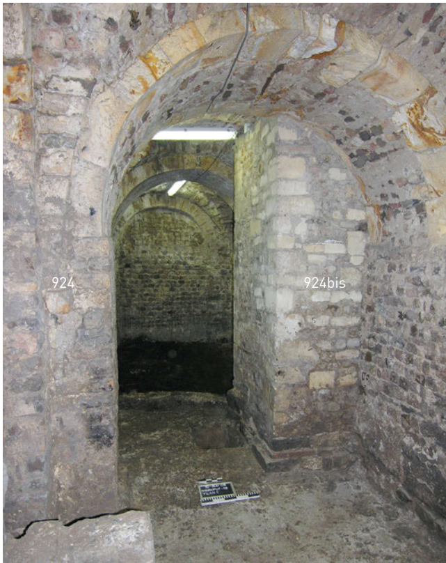
FIG. 1.76 Tongeren: O.L.V.-basiliek: werkput 18: romaanse kelder (spoor 924) en gotische fundering (spoor 924bis) vanuit het westen.
