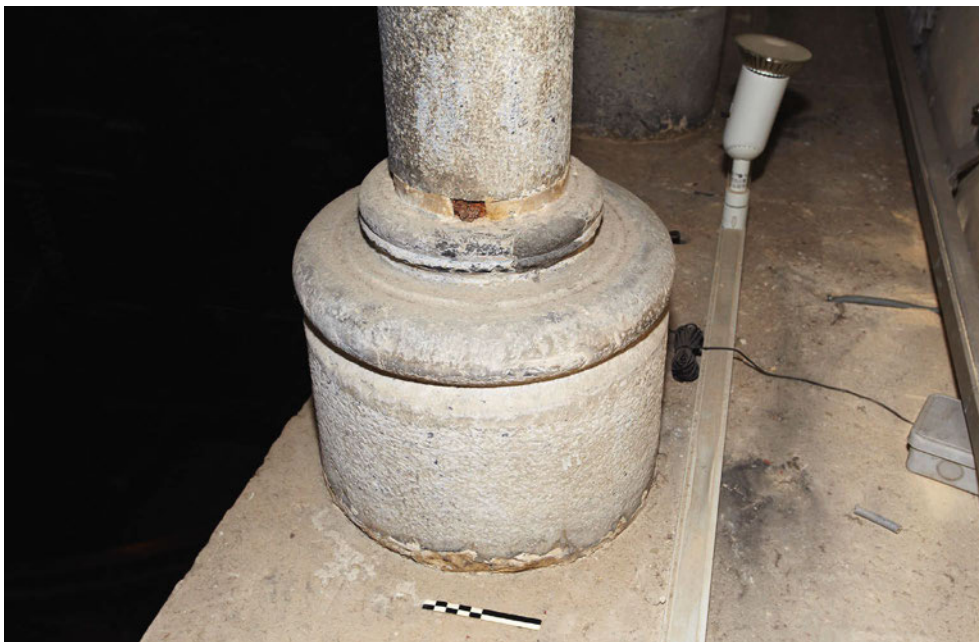
FIG. 2.39 Tongeren: O.L.V.-basiliek: sokkel en zuil in het noordelijke triforium van de eerste westelijke travee van het schip, met populieren stelwig in de voeg tussen sokkel en zuil.
