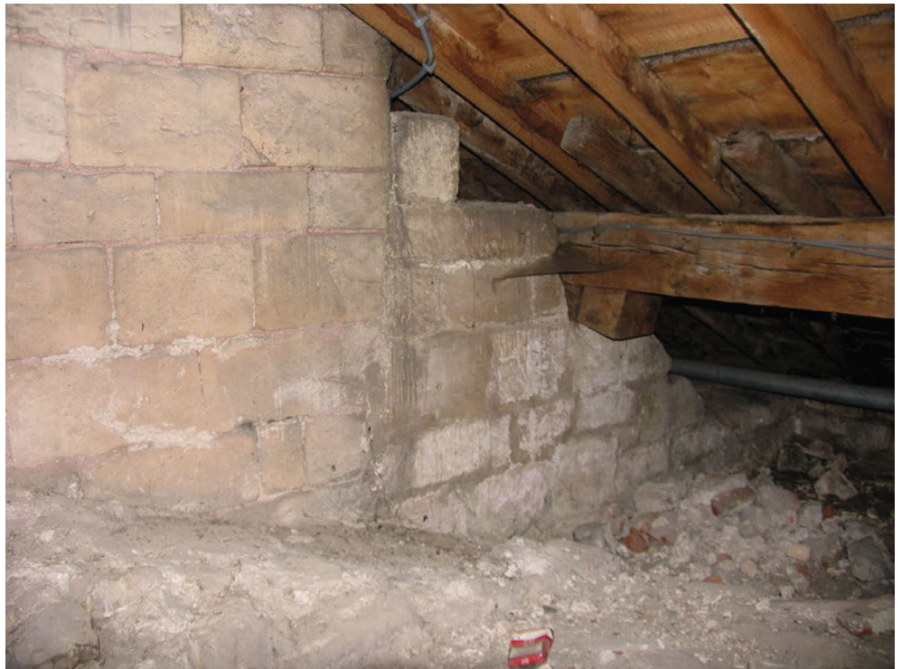
FIG. 2.35 Tongeren: O.L.V.-basiliek: luchtboogstoel tussen de tweede en de derde oostelijke travee van het schip (noordzijde). Het metselwerk van de luchtboogstoel is gevoegd in roze mortel, dat van de later aangebouwde muur van de zijkapel in witte mortel.
