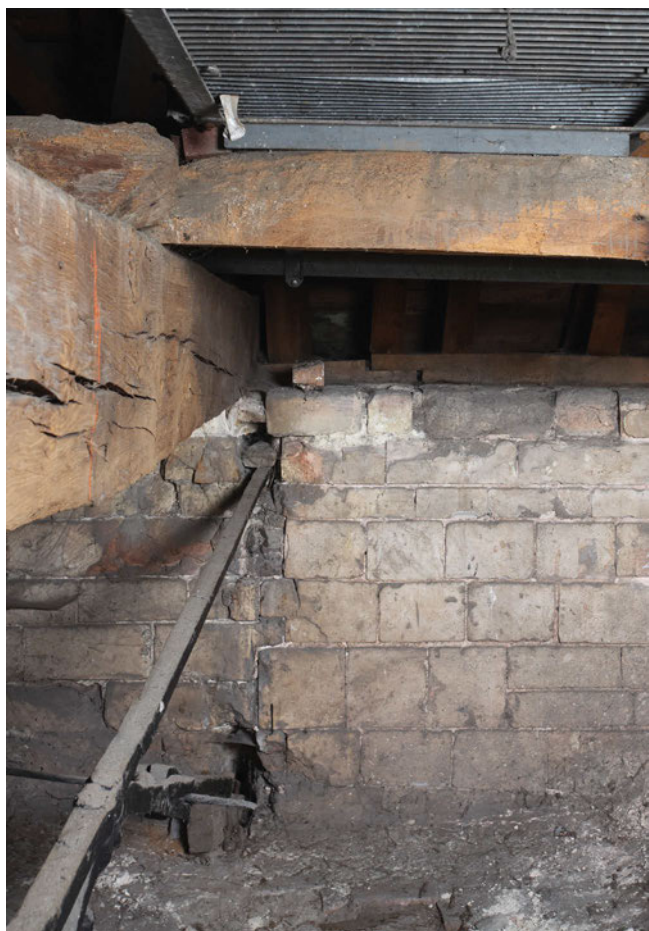
FIG. 2.20BIS Tongeren: O.L.V.-basiliek: metselwerk van het koor boven de gewelven (noordzijde), met bouwnaad tussen de tweede en de derde westelijke travee (onbewerkte detailfoto).
