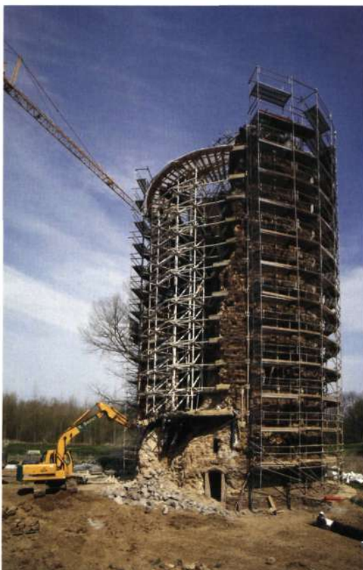
De zuidwestzijde met verticale scheur bovenaan in 2004 (foto K. Robijns)
