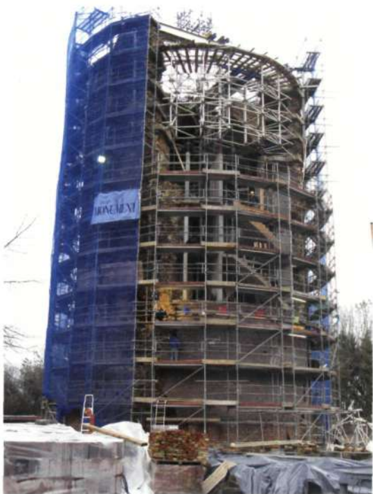
De stutstructuur wordt geleidelijk aan weggenomen en vervangen door de betonnen schijfwanden, de trappen en de Kolumba-wand (foto H. Thibaut)
