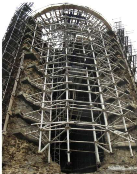
De stutstructuur wordt geleidelijk aan weggenomen en vervangen door de betonnen schijfwanden, de trappen en de Kolumba-wand (foto H. Thibaut)
