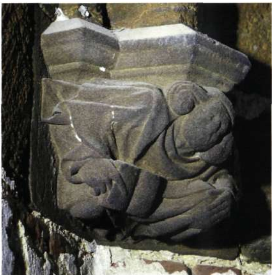
Een vervangen kraagsteen (foto L. Van Dijk)
