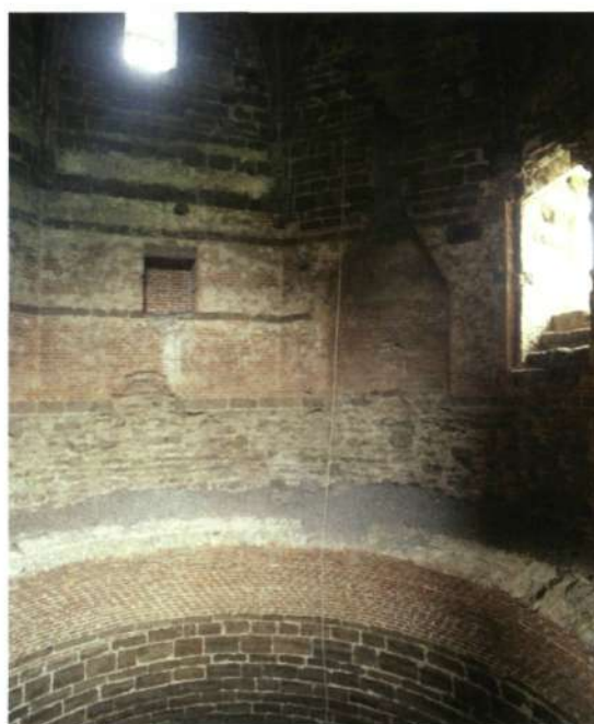
De eerste verdieping met bakstenen parement en speklagen in ijzerzandsteen. Helemaal bovenaan het kleine venster, rechts het zuidelijke deur-venster met trap. In het midden één van de twee nisvormige schouwen. Onder de schouw het uitbraakspoor van het koepelgewelf van het gelijkvloers (foto O. Pauwels)
