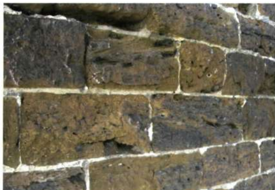
Het verweerde parement in Diestiaan ijzerzandsteen (foto H. Thibaut)
