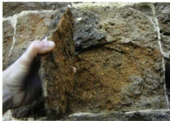
Harde korsten komen los van de achterliggende verzande steen (foto H. Thibaut)
