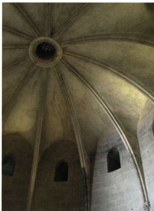
Ribgewelf op het gelijkvloers van de grote ronde Philipijnse toren in Aigues-Mortes (foto F. Doperé)
