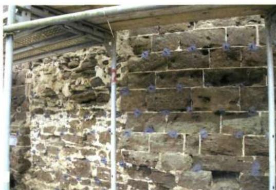
Vorbereiding van de torenwand voor injectie met injectiemortel: geplaatste injectienippels (boven) en coating in thermoplast als bescherming tegen uitlopers van injectiegroot (onder) (foto's M. Vanderauwera)
