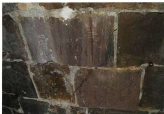
Herstelling met gedateerde parementsteen in Bontzandsteen (1896) (foto H. Thibaut)
