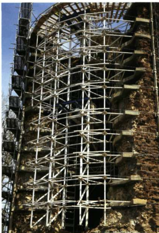
De toren met stutstructuur in de bres en voorgespannen kabels (foto H. Thibaut)
