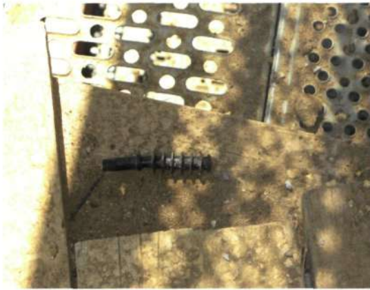
Injectienippel (foto's H. Thibaut)
