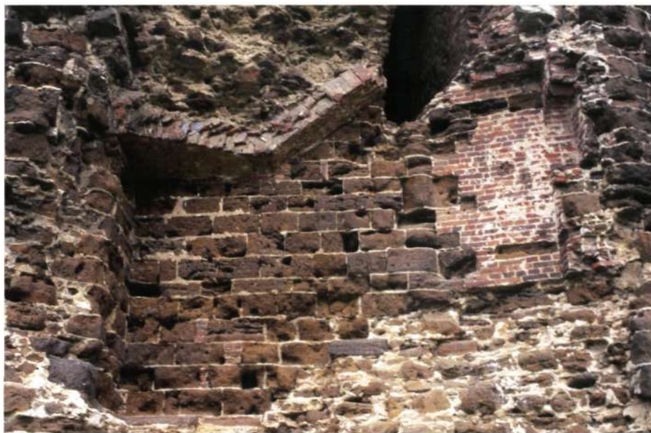
De sporen van de toegang tot de toren (links), de gang en de steektrap (midden) en de met baksteen dichtgemetselde toegang tot de traptoren (rechts) (foto M. Ubregts, 1988)
