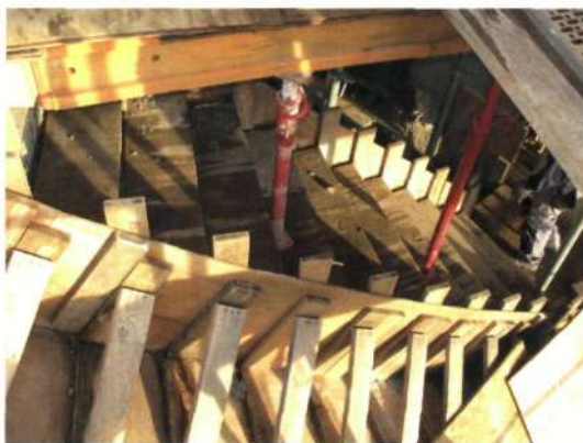
Bekisting van de betonnen trappen (foto's H. Thibaut)
