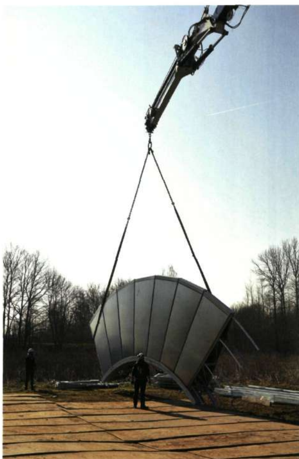
Plaatsing van het dakplatform (foto's K. Vandevorst)
