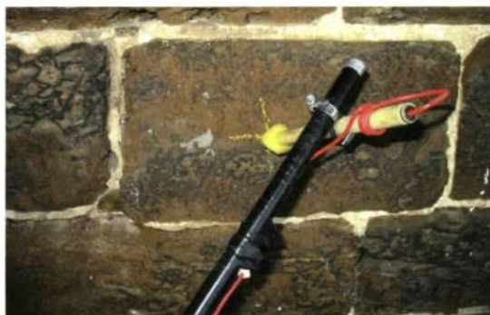
Detail van een meetelektrode (foto Ingenieursbureau Norbert Provoost bvba)
