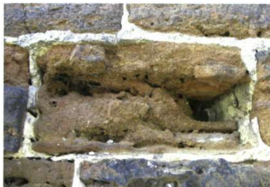
Volledig verzande steen met uitvliegopeningen van metselbijen (foto H. Thibaut)
