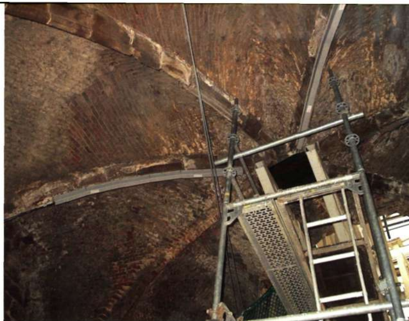
Optische koord op de gewelven (foto Ingenieursbureau Norbert Provoost bvba)
