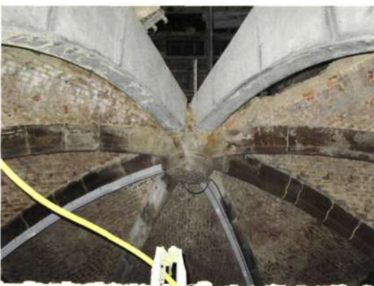
De schijfwanden sluiten aan op de sluitsteen van het gewelf en vervangen de ingestorte gewelfribben (foto H. Thibaut)
