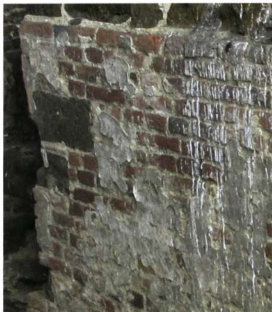
Testzone uit 2011, links vóór behandeling, rechts na verwijderen van de thermoplast. De laag cyclododecaan bleef ongeschonden bewaard (foto L. Van Dijk)
