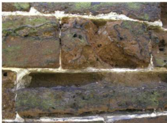
Harde limonietkorsten en verzande delen in eenzelfde steenblok (foto H. Thibaut)
