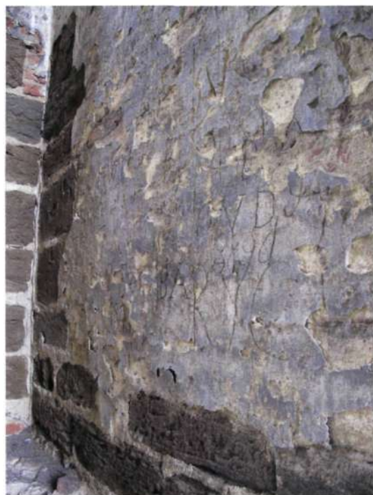
Opstuwingen en lacunes in de afwerkingslagen (foto L. Van Dijk)
