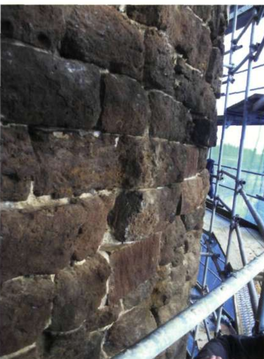
Vervanging met Brusseliaan ijzerzandsteen (foto M. Vanderauwera)
