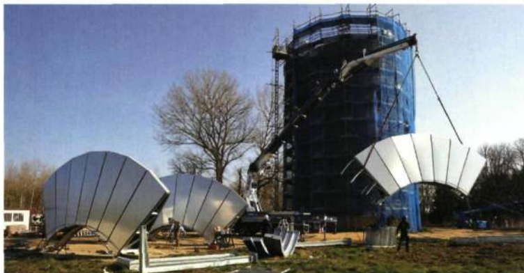
Plaatsing van het dakplatform (foto's K. Vandevorst)
