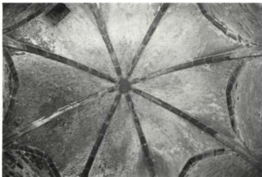
Het achtdelig ribgewelf op de eerste verdieping, toestand in 1988 (foto M. Ubregts)
