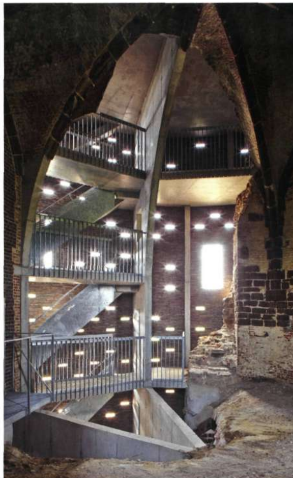
(links) Het contrast tussen de oude ijzerzand- stenen en de invulling in Kolumba-steen (foto K. Vandevorst)
