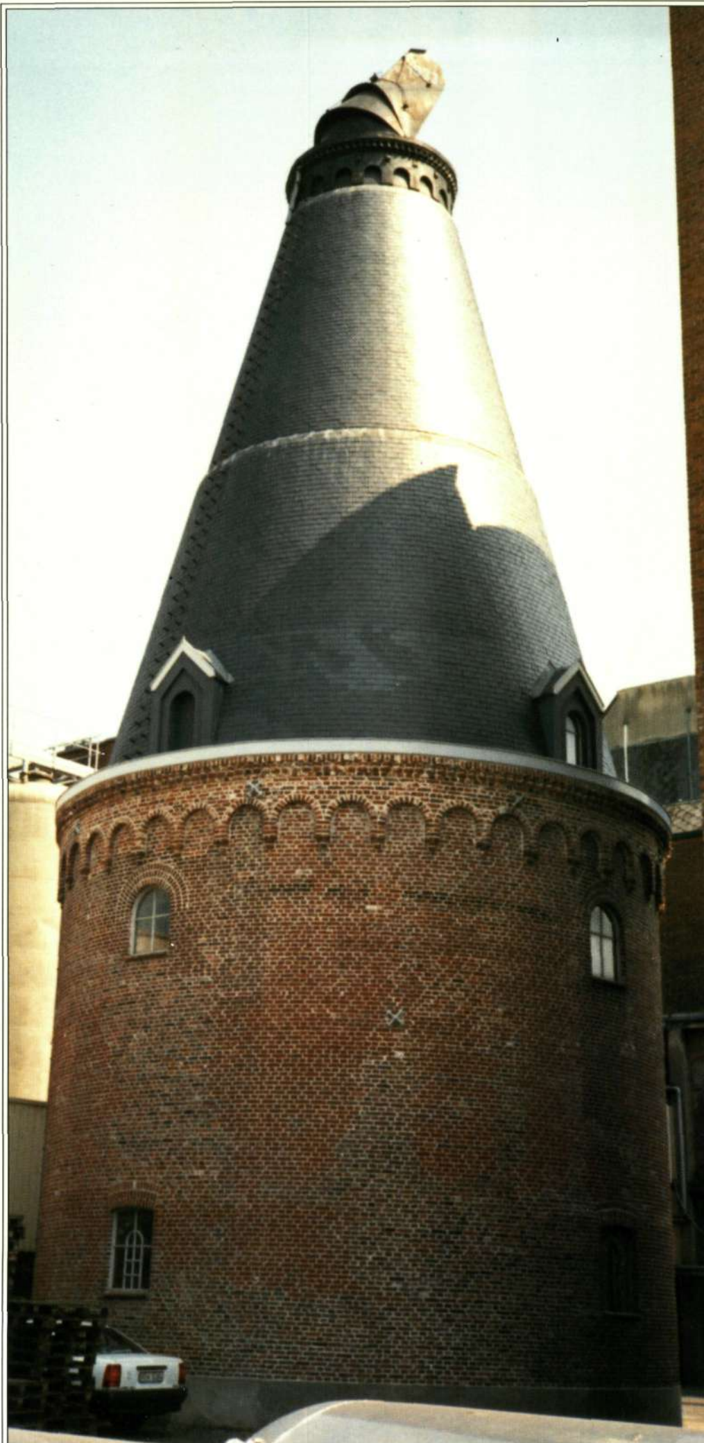
Ast van de Brouwerij Rodenbach na restauratie
