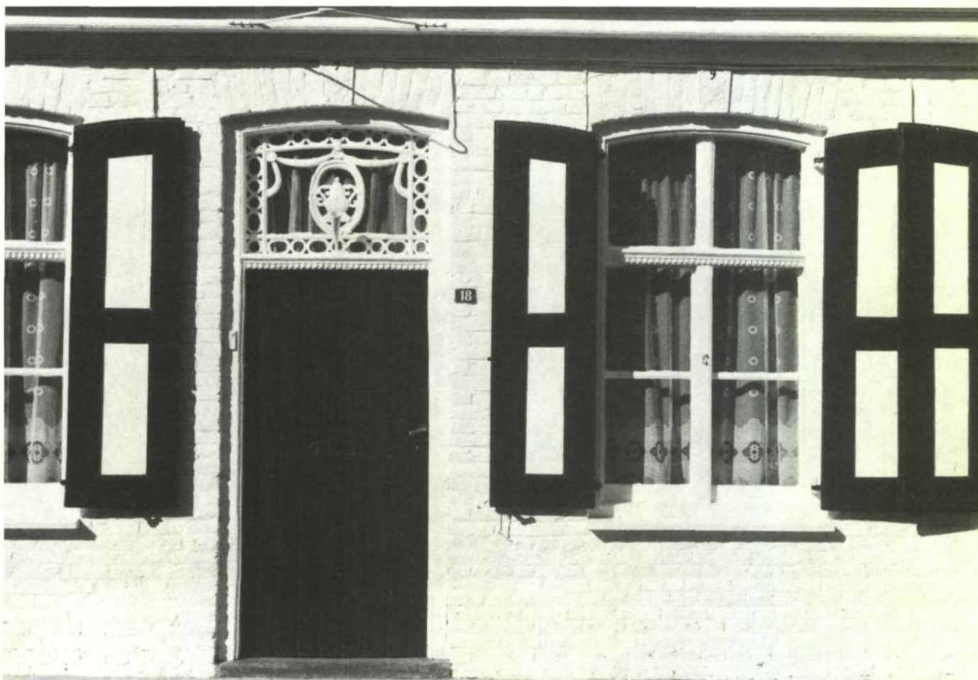
Watou. Vijfhoekstraat nr. 18. Kozijnconstructies (1799)
