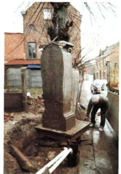
De zuil wordt gelicht (eigen foto)
