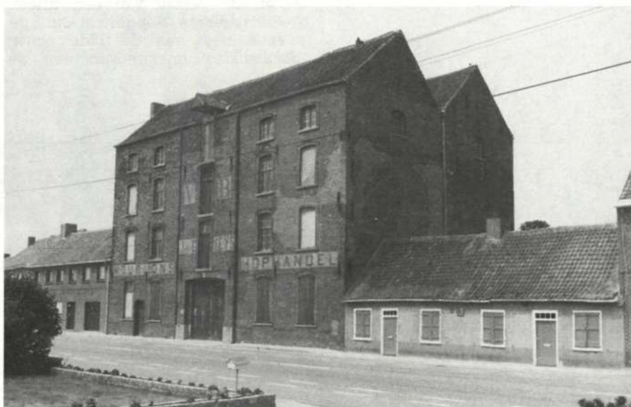
Vlamertinge. Poperingseweg nr. 322. Voormalig hopmagazijn
