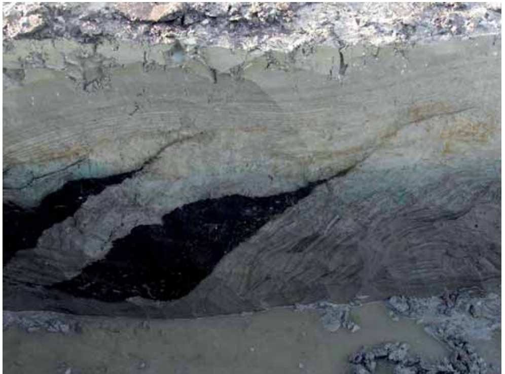
FIG. 52 Natuurlijke sedimentatie boven het door mensenhanden opgeworpen dijklichaam. Water-deposited stratified layers overlying the manmade embankment.
