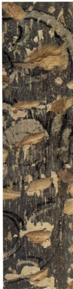
Bij het aanbrengen van een nieuwe bepleistering werd vaak de vorige laag ingekapt voor een betere hechting, hier op een fragment uit het kasteel Vilain XIII te Leut (foto M. Buyle)
