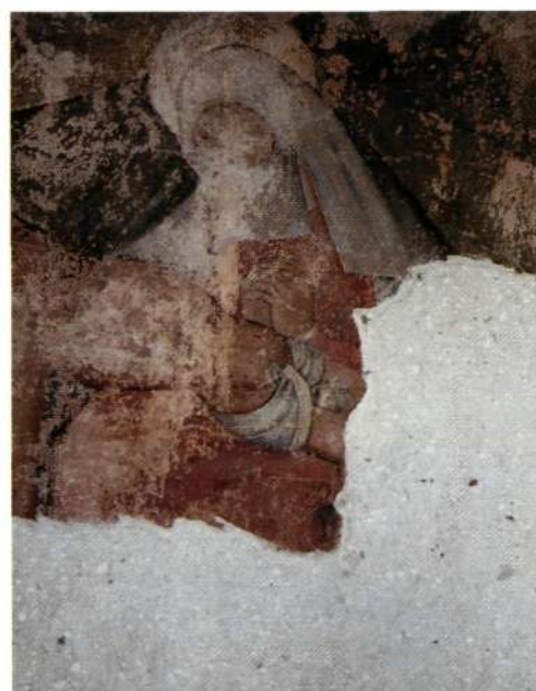
Pieta uit de crypte van Sint-Baafskathedraal te Gent, waarbij onderaan de bovenlaag is afgefallen en de onderste ruwe kalkbepleistering zichtbaar wordt (foto M. Buyle)
