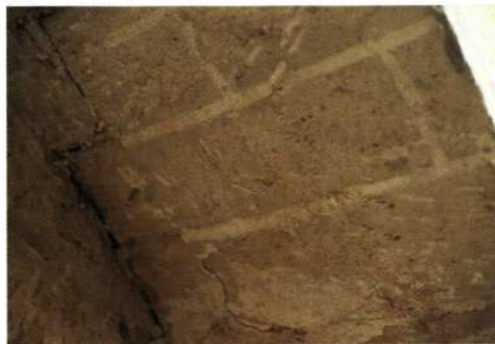
◀ Voegwerkimitatie in de sacristie van de Sint-Jan-de-Doperkerk te Leuven (foto A. Bergmans)
