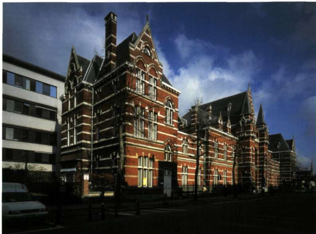
► Voorgevel van het hoofdgebouw van het Stuyvenberggasthuis in Antwerpen (foto K. Vandevorst)
