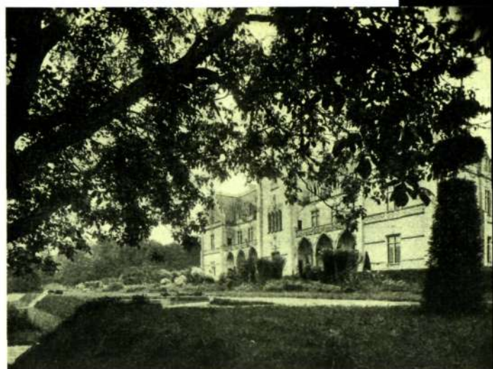
▲ De terrassen van de door Van der Swaelmen ontworpen omkadering van het kasteel (archief Aalmoezeniers van de Arbeid, Meldert)
