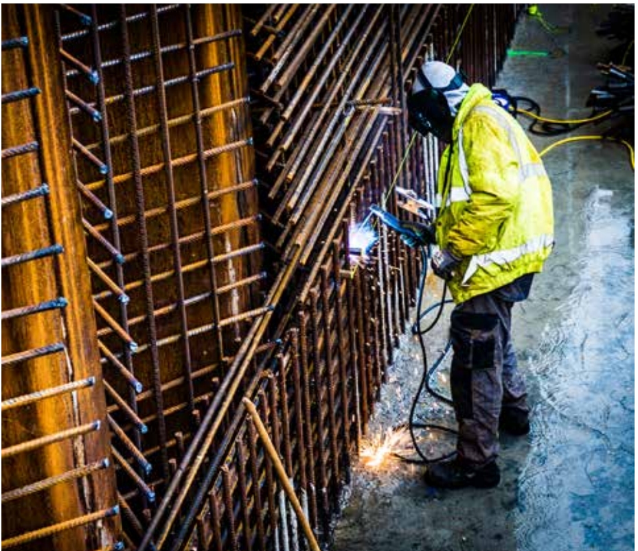
De testdijk in volle opbouw.
