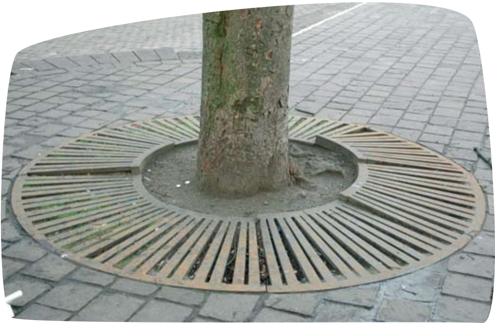
Een boomrooster wordt door de diktegroei van de boom soms opgeduwd, met gevaarlijke situaties tot gevolg.
