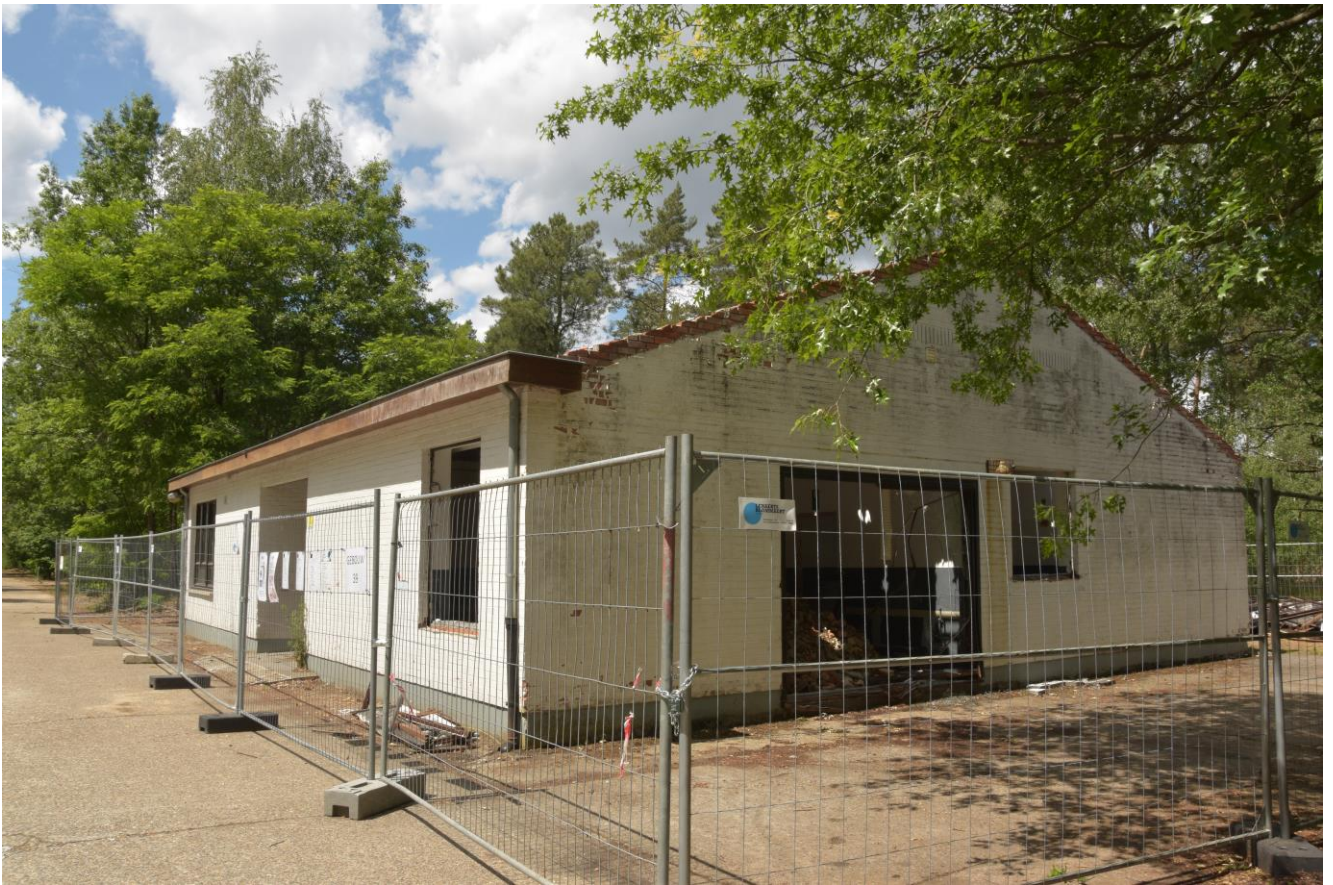
Afbraak gebouw 39, de Hoge Rielen
