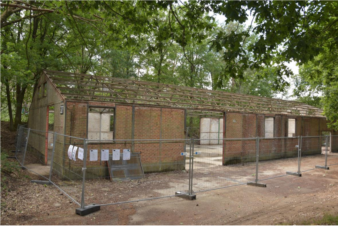
Renovatie gebouw 27, de Hoge Rielen
