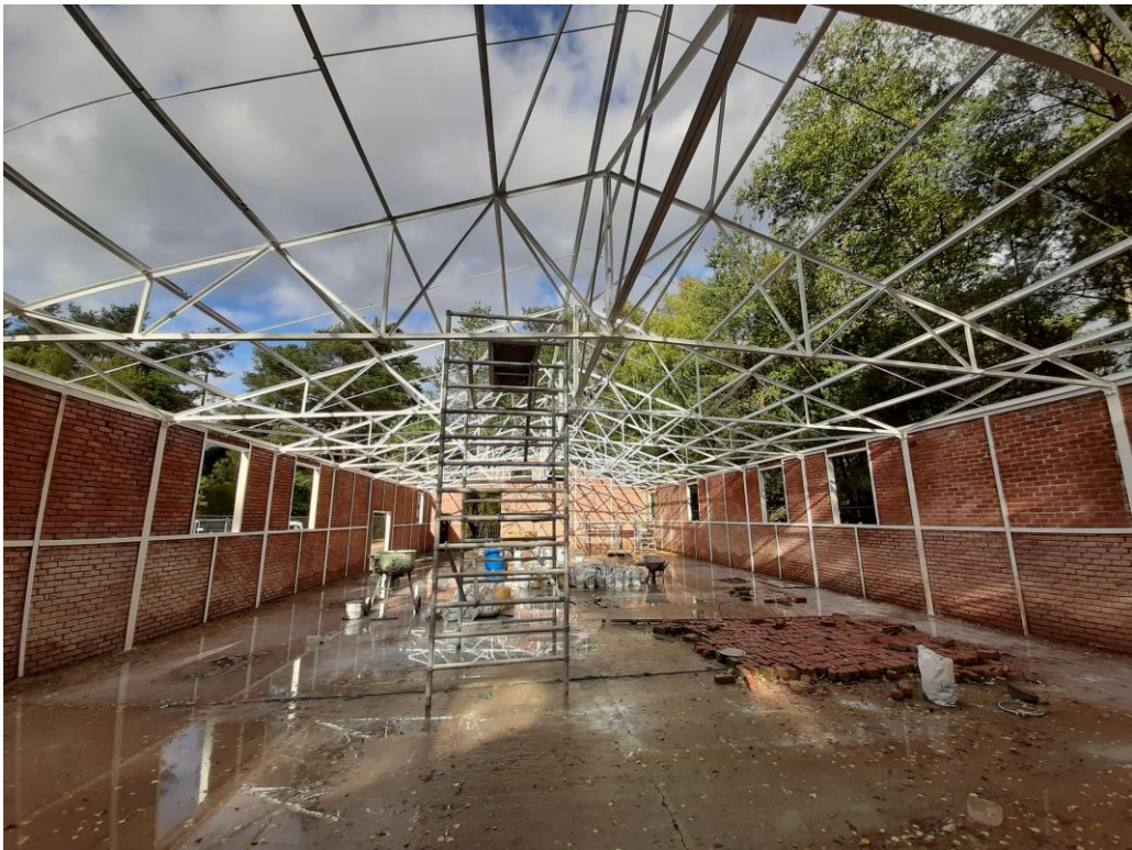
Renovatie gebouw 30, de Hoge Rielen
