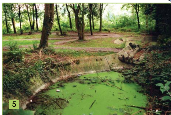
Oude betonnen bronvijvers
