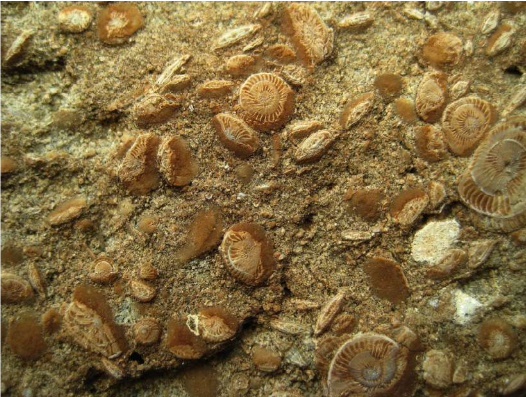
FIG. 55. Detail van het oppervlak van een Nummulietenkalksteen als bouwsteen (Pollare, W-Vlaanderen).
