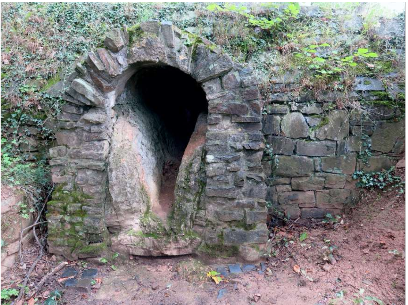
FIG. 74. Afzetting van kalksinter (“Aquaductmarmer”) in een deel van het Romeinse Eifelaquaduct bij Euskirchen-Kreuzweingarten (Duitsland). De maximale dikte van deze kalksinter is hier ca. 30 cm.
