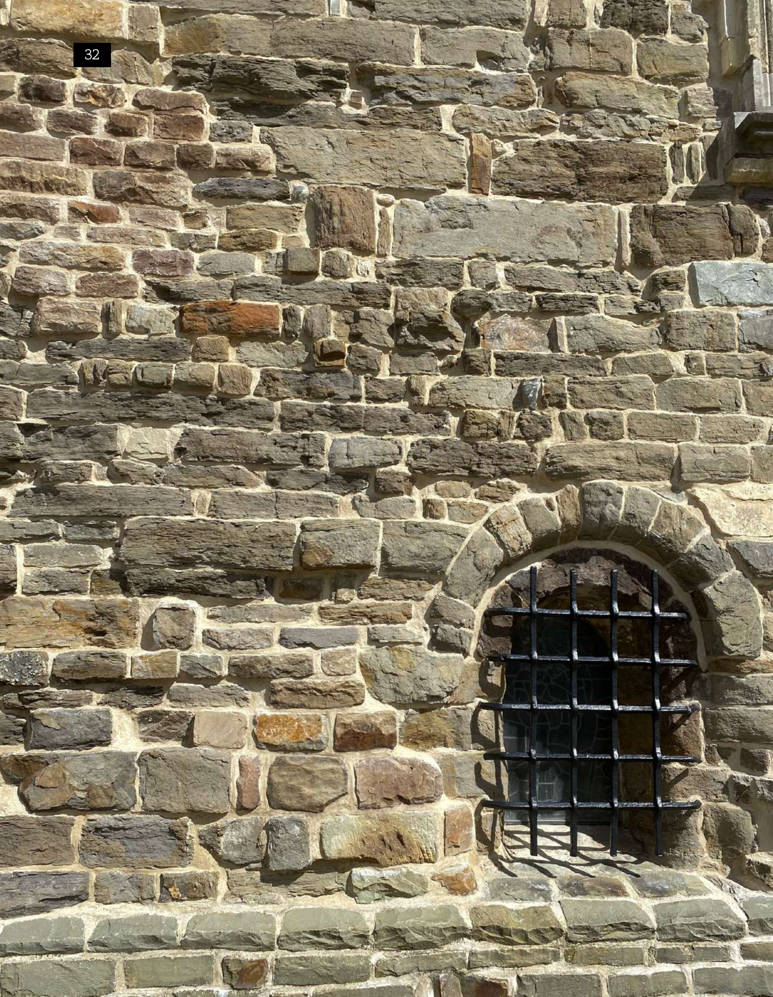
Onderkant van het (oudere) westwerk van de 14e eeuwse St.-Michaëlskerk van Thorn (Nederland), hoofdzakelijk gebouwd in Carboonzandsteen. Voor de gerestaureerde ondermuur werd Famenniaanzandsteen gebruikt.
