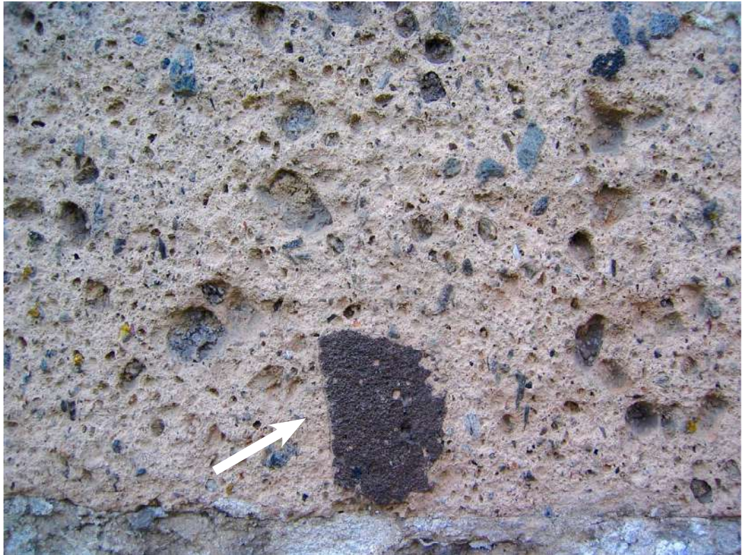
FIG. 51. Vulkanische tufsteen uit de muur van het schip van de abdij van Postel.
