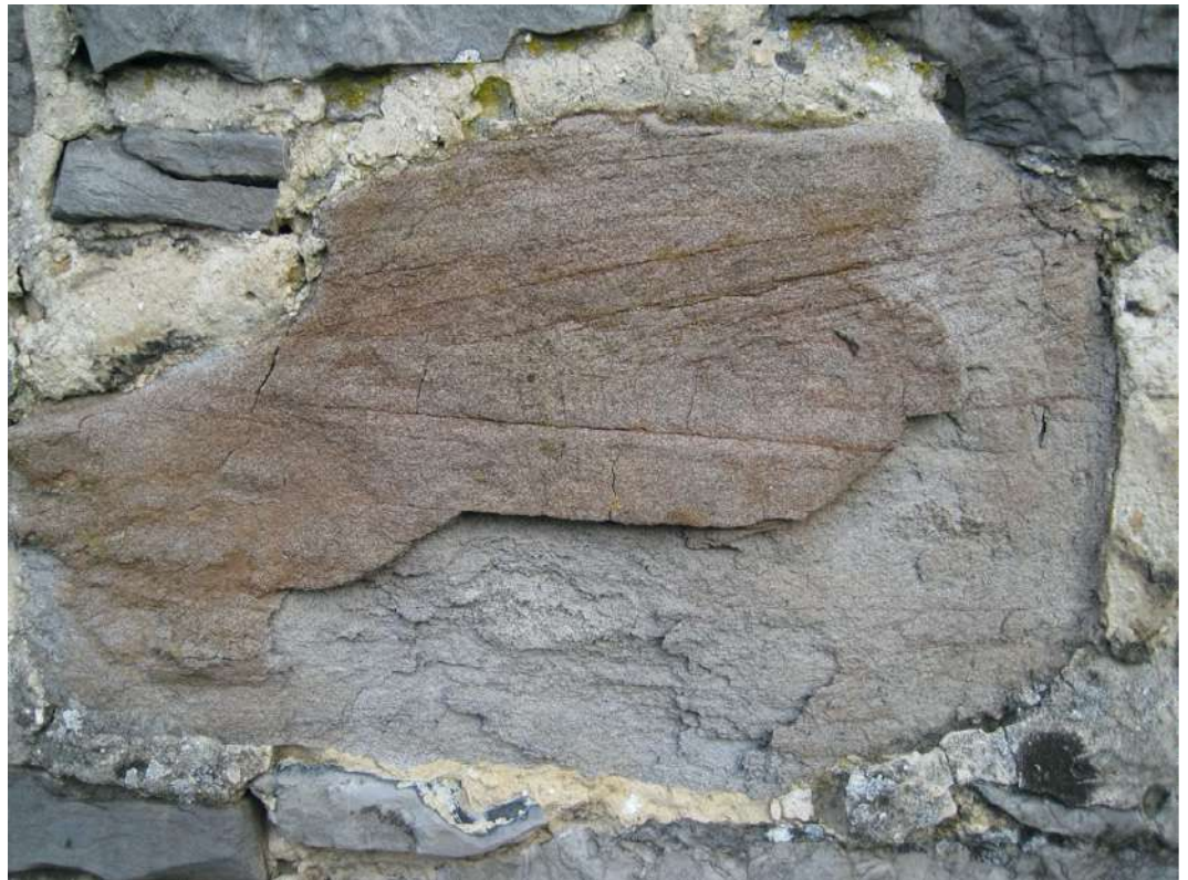
FIG. 16. Historische bouwsteen (Middeleeuws) met duidelijke gekruiste gelaagdheid en karakteristieke bruine patina. Door fysische verwerking gaat de steen afbladderen. Middeleeuwse stadswal Maastricht.
