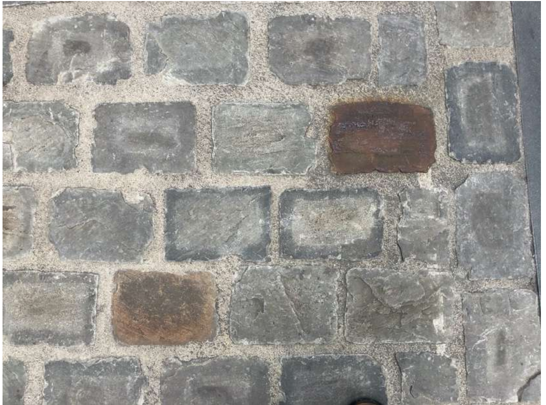
FIG. 104. Bruin verkleurde oppervlakken van platines in Indische zandsteen.
