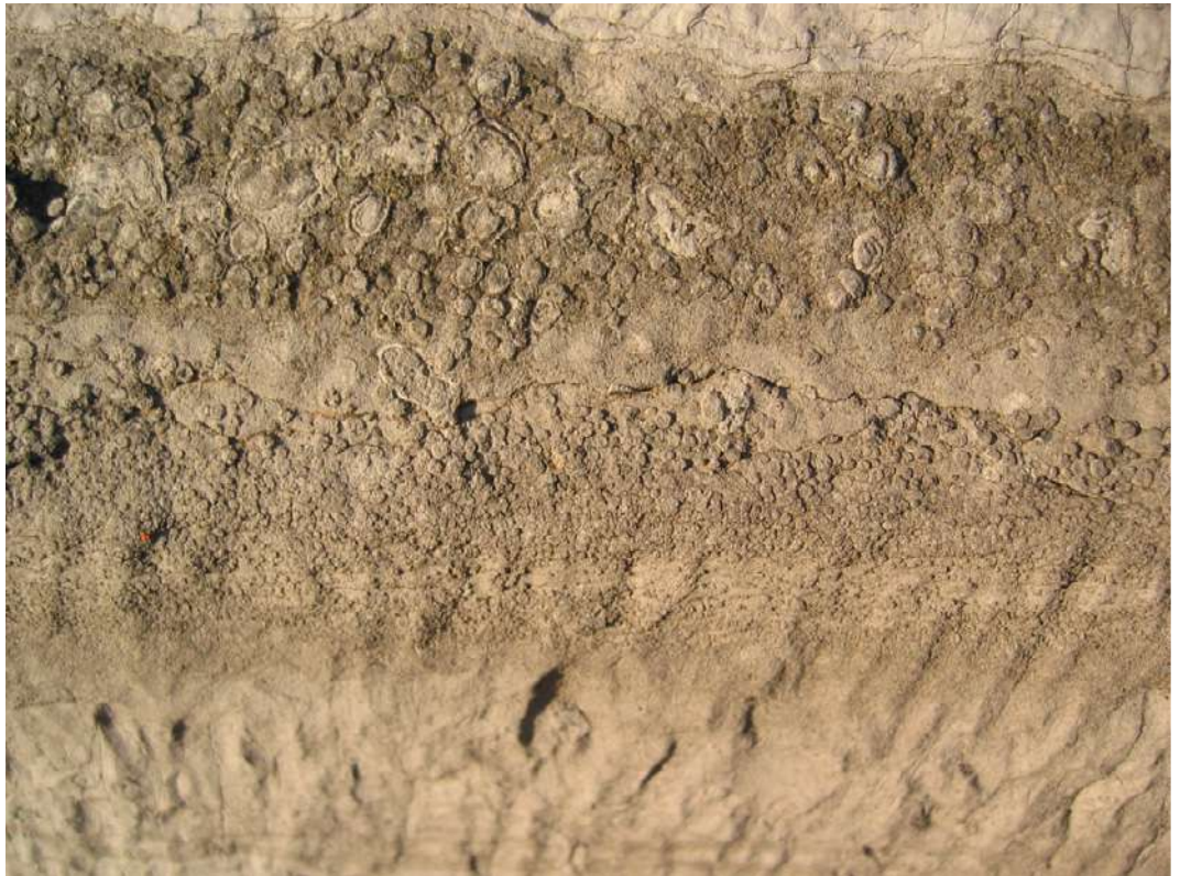
FIG. 83. Detail van verweerde Maaskalksteen met kleine oncoïden, St.-Aldegondiskerk in Alken.
