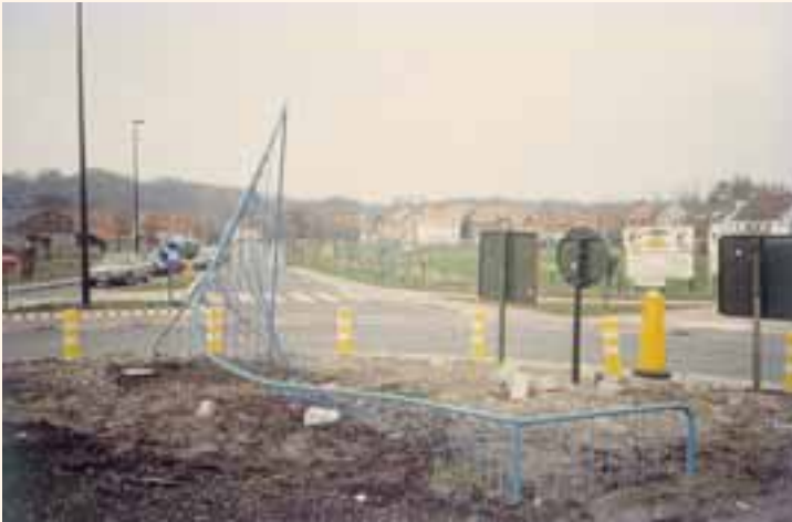
foto Guy Châtel
