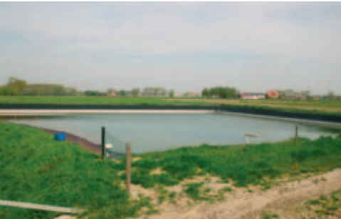
Op substraatbedrijven met vruchtgroenten wordt veelal een folievijver aangelegd om hemelwater in op te vangen.
