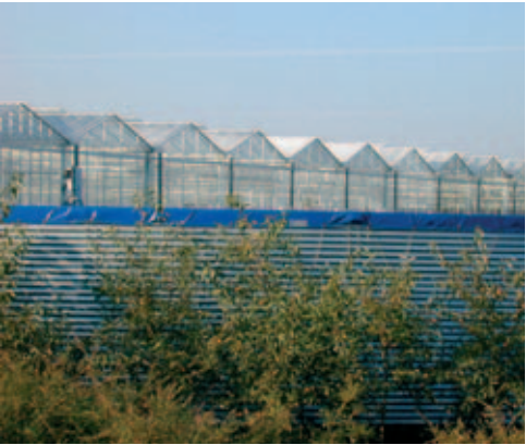
Een metalen silo neemt minder plaats in dan een folievijver, maar wordt duurder dan een folievijver bij grote opslagvolumes.
