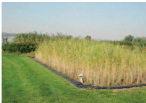
Rietveld voor de behandeling van restdrainwater.
