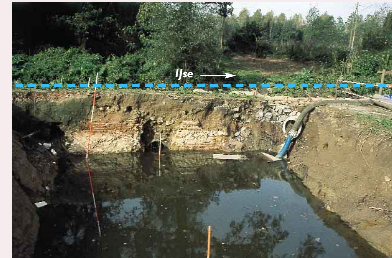
Afbraak sifon uit de 17de eeuw en realisatie open verbinding IJse-Leigracht.
