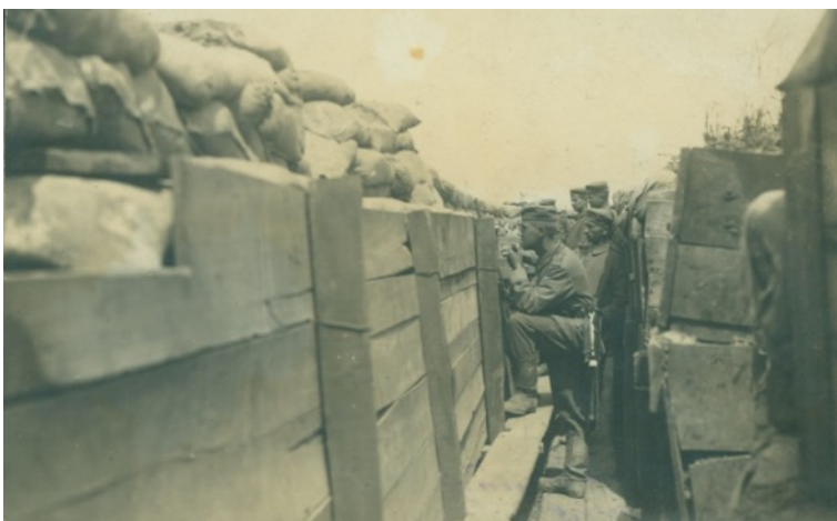
Fig. 7-24 Bekleding met horizontale planken in een Duitse loopgraaf (© IFFM IFFF000067R).
