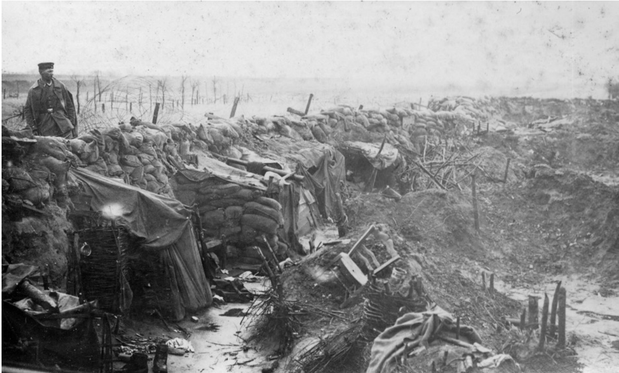
Fig. 7-28 Loopgraven opgebouwd uit zandzakken (© IFFM).
