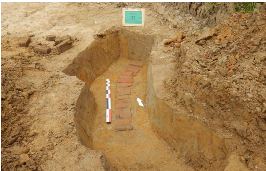
Fig. 7-49 Eenvoudige bakstenen vloer in LPG_ID168 waarbij slechts 1 steen breed is gewerkt (© THV MRG).
