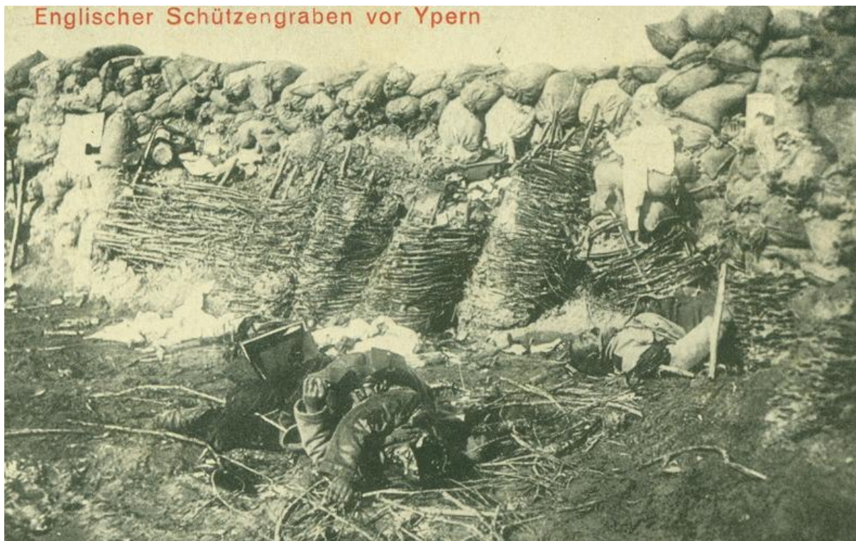
Fig. 7-19 Ook de geallieerden gebruikten vlechtwerk, zoals bij deze Britse loopgraaf (© IFFM IFFF000025)
