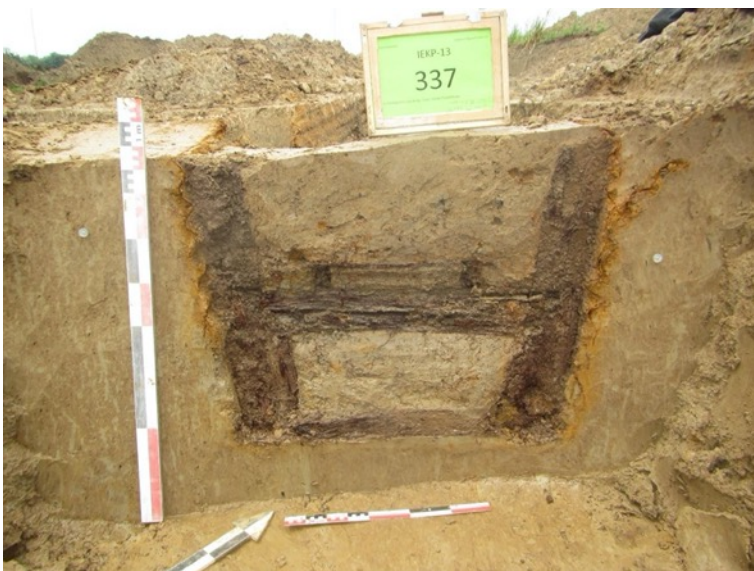
Fig. 7-17 Dwarsdoorsnede van diezelfde LPG_ID2 met het golvend patroon van de golfplaten langs de buitenzijden van het profiel en op hun plaats gehouden door een A-frame (© VEC).
