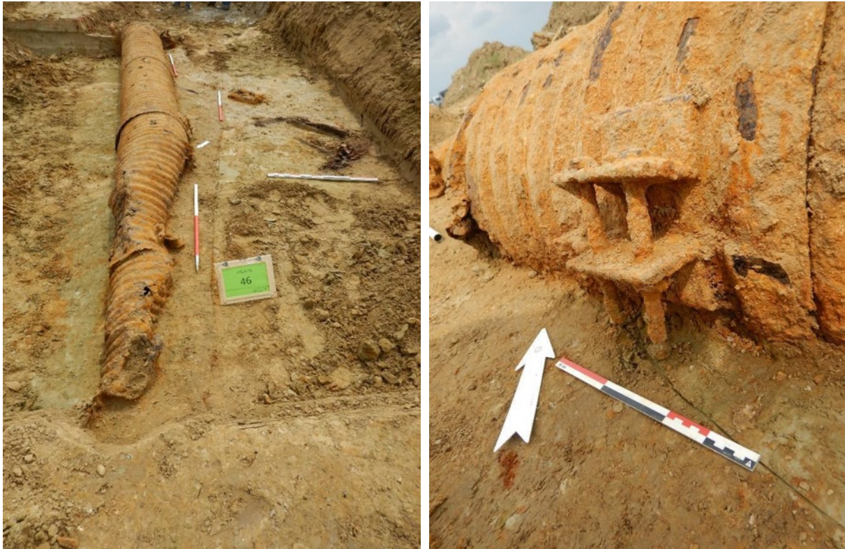
Fig. 7-68 Overzicht- en detailopname van de ijzeren rioolbuis achter LPG_ID178 (© THV MRG).
